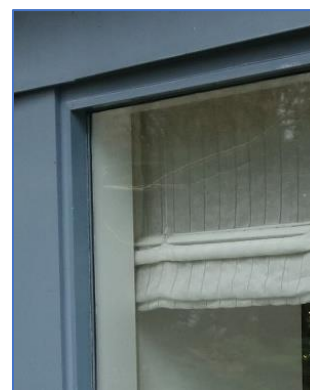
Figuren 16. Verschillende opties voor de buitenzijdige opbouw van het houten kozijn met de glaslat aan de buitenkant of in de dag van het kozijn. Dit heeft de voorkeur boven het uitfrezen van het kozijn.
