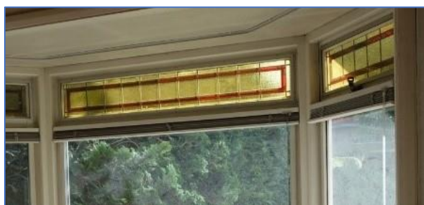
Figuren 5. Bij dit GIL bovenraam zit er al aan de binnenzijde een aluminium frame achterzetruit ( R_c = 0,35 ). Door die achterzetruit naar de buitenkant over te zetten, wordt het GIL goed beschermd. Aan de binnenkant kan dan een HR ++ geplaatst worden een luchtspouw van 18 mm (nieuwe R_c = 0,35 + 0,2 + 0,9 = 1,45 ) wat \approx 3x zoveel isolatiewaarde oplevert.
