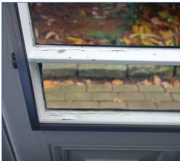
Figuren 4. Links : Buiten enkel glas en binnen een achterzetruit. Vocht is achter de ruit gekomen en de verf breekt door zwelling van het hout, waardoor er weer meer vocht in het hout kan trekken en gaat het rotten. Rechts : Enkel glas ruit met condens druppels. De kitvoeg heeft hier zwarte schimmelafzetting in de hoek.
