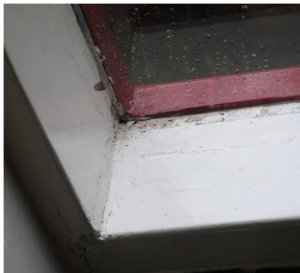
Figuren 4. Links : Buiten enkel glas en binnen een achterzetruit. Vocht is achter de ruit gekomen en de verf breekt door zwelling van het hout, waardoor er weer meer vocht in het hout kan trekken en gaat het rotten. Rechts : Enkel glas ruit met condens druppels. De kitvoeg heeft hier zwarte schimmelafzetting in de hoek.
