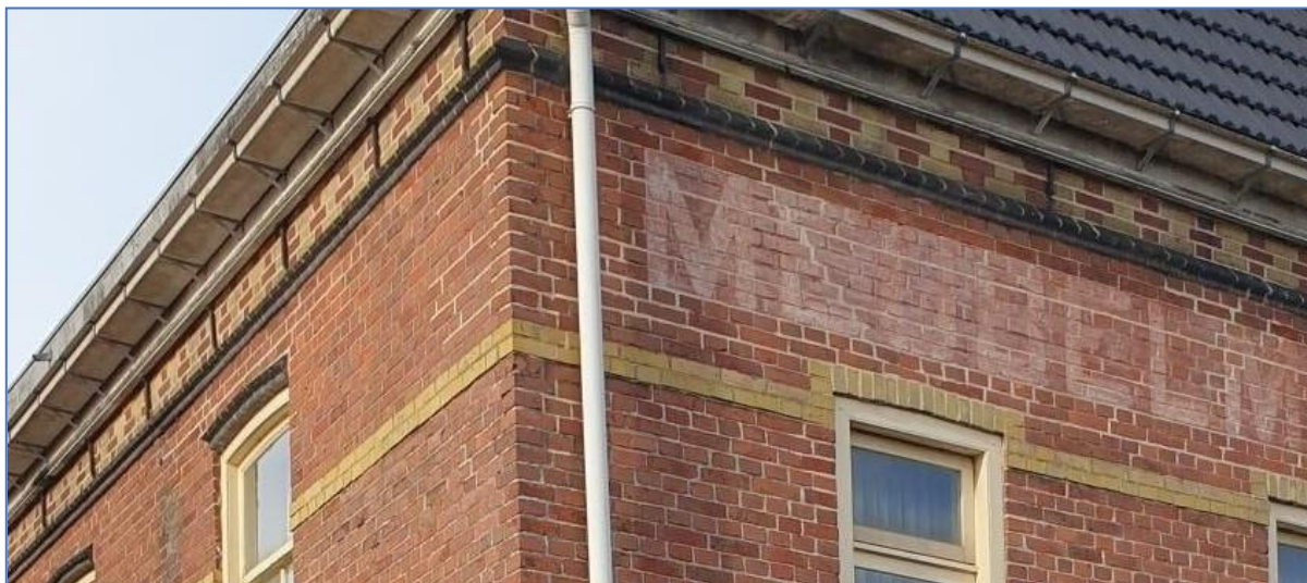
Figuur 64. Detail van steens muur hersteld met lintvoegwapening. (foto Mick Eekhout)
