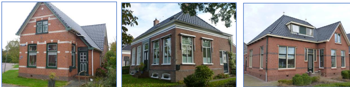
Figuren 73. Voorbeelden van veel voorkomende woningtypen in de provincie Groningen die steens muren hebben en in cementmortel zijn opgetrokken. De middelste woning heeft met de kelder nog een extra complicatie wanneer deze niet onder het hele gebouw doorloopt.
