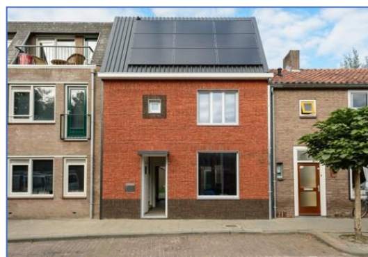
Figuur 42. Door het aanbrengen van een nieuwe buitenschil met isolatie en afgewerkt met steenstrips of ander materiaal zullen kleine scheuren in de draagmuren niet meer zichtbaar zijn. Bij niet groter wordende bevingen kan ook de binnenmuur iets flexibel worden afgewerkt.
