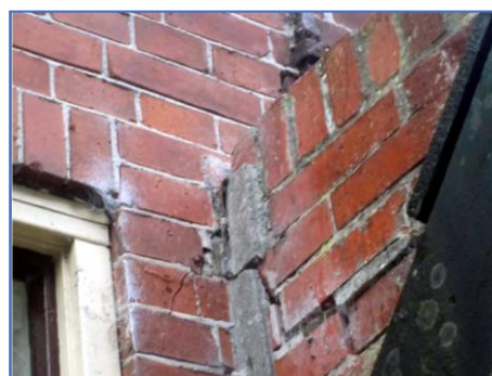
Figuren 58. Van een heleboel schades, vooral aan de oudere steens muren gebouwen, was het zonder meer duidelijk dat deze schades er al jaren zaten; schades die soms verergerd waren door de bevingen. Veel schades waren het gevolg van bouwfouten. Het alleen dichtsmen van de scheuren is dan geen oplossing van het onderliggende probleem. Bij een volgende beving staan die scheuren dan weer open. Het aanbrengen van gebouwdilatatie is dan een belangrijk onderdeel.
