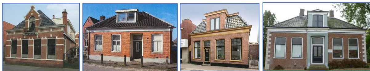
Figuren 50. Verschillende ‘rentenierswoningen’ die tot dezelfde typologie behoren, maar toch allemaal verschillend zijn uitgevoerd, omgebouwd, verschillende funderingsproblemen hebben en al-dan niet goeden verbindingen tussen de vloeren en de dragende muren. Deze kunnen niet allemaal met een enkele typologie VA op dezelfde manier versterkt worden. Om dit goed aan te pakken is begrip nodig bij de lokale aannemers.
