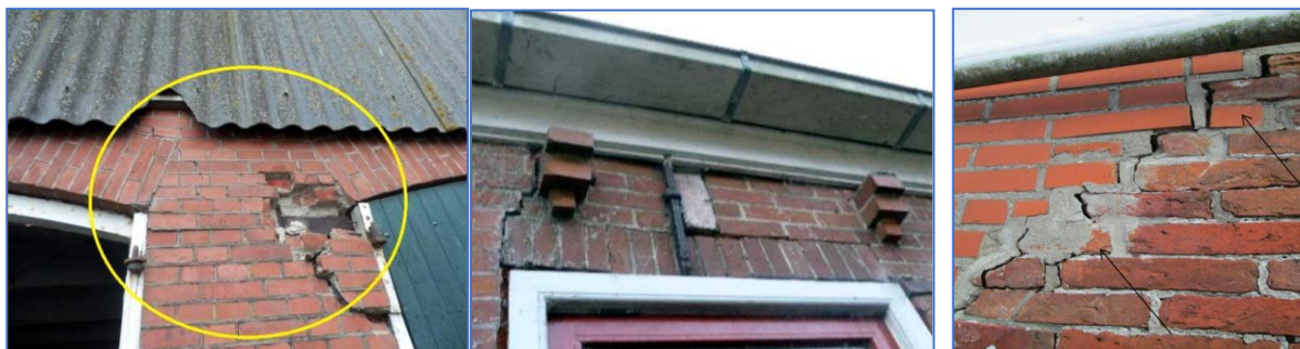
Figuren 58. Van een heleboel schades, vooral aan de oudere steens muren gebouwen, was het zonder meer duidelijk dat deze schades er al jaren zaten; schades die soms verergerd waren door de bevingen. Veel schades waren het gevolg van bouwfouten. Het alleen dichtsmen van de scheuren is dan geen oplossing van het onderliggende probleem. Bij een volgende beving staan die scheuren dan weer open. Het aanbrengen van gebouwdilatatie is dan een belangrijk onderdeel.
