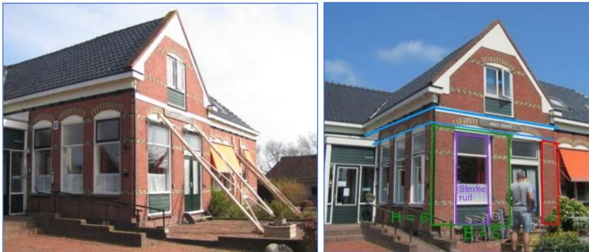
Figuren 82. De raam- en terrasdeur penanten hebben ongeveer een breedte/hoogte verhouding van 1/4,5 = 0,22 en voor een PGAg 0,1 te weinig. Aan de zijkant is het niet beter.
