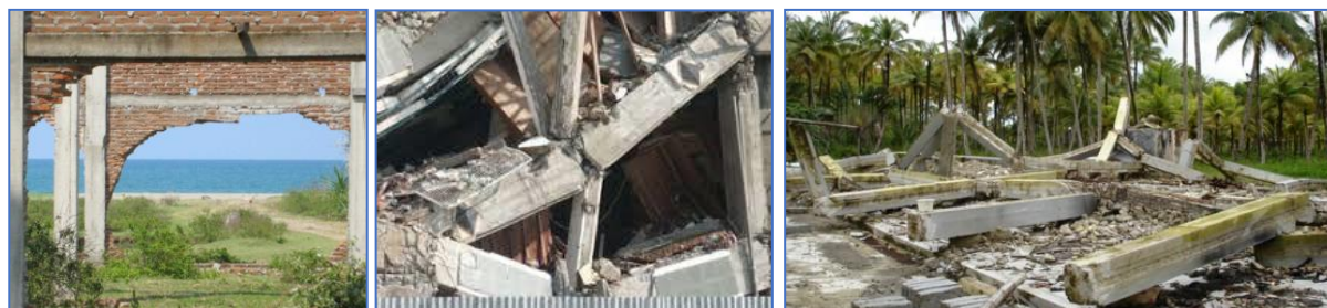
Figuren 60. Images van Tsunami: Cordia Medan beving en nog staande nadat de tsumani de muren eruit sloeg. Midden: Bandah Aceh beving foto van www.iitk.AC.in in de stad. Rechts Parish, Indonesië met combinatie van beving en de vloedgolf. Door een niet-versterkte en ductiele wapening in de maximale moment locaties van de klossen ontstaat fatale gebouw instorting.
