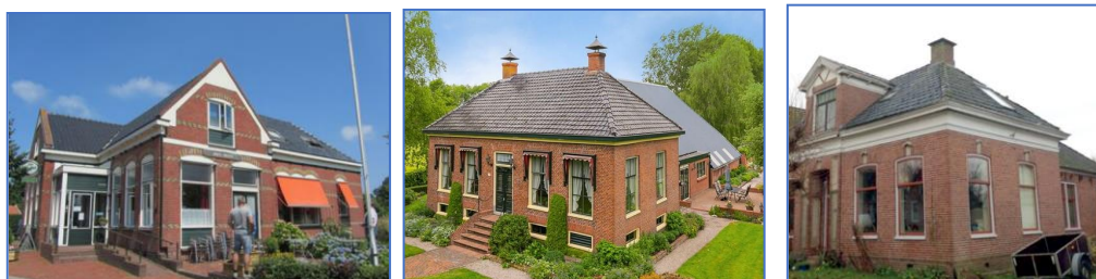
Figuren 29. Veel woningen in de provincie vallen onder de pré 1900 categorie met steens muren en zonder verbindende rondgaande lateiconstructie en zonder verbindend etage vloerdiafragma.
