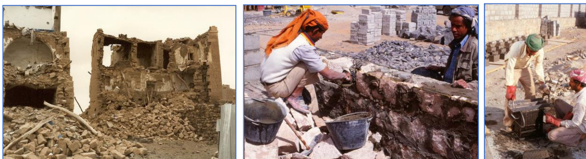
Figuren 55. Na de aardbeving was er veel steen materiaal voorhanden. Met de productie van een U-cementblok kon op eenvoudige manier seismische wapening ingebracht worden en strak gemetseld.
