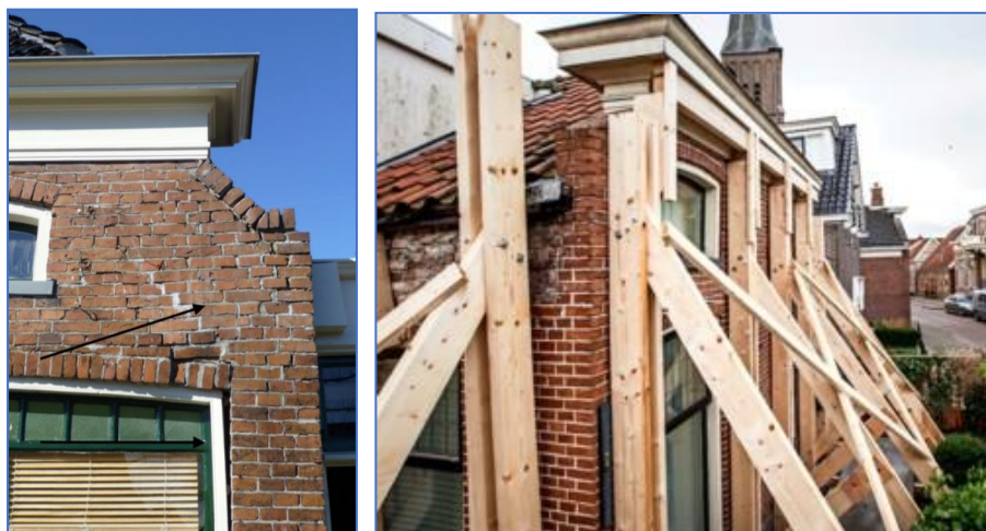
Figuren 44. Voorbeeld. Veel oude woningen hebben gelijksoortige problemen en lopen een gedeeltelijk instort risico bij herhaalde bevingen. Stutten is dan wel noodzakelijk.
