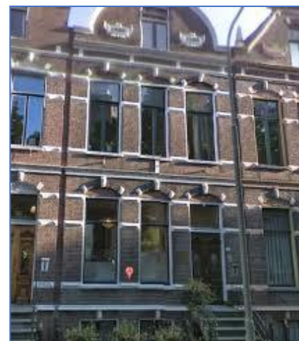
Midden: Om het vroegere aanzicht van de oude ruiten te behouden kan op het sterke vaste glaspaneel een imitatie strook gelijmd worden en in de kleur van het vroegere raam geschilderd (beschermd stadsgezicht).
