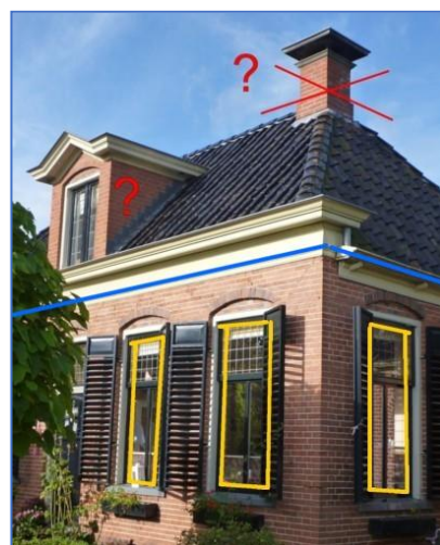
Figuur 91. Bij dit gebouw met slechts een etage op zolder zal ten eerste de gemetselde schoorsteen als hoog-risico element moeten verdwijnen, maar dat is niet in lijn met het cultureel erfgoed principe. Vervangen door een lichtgewicht model is dan de optie. Wanneer binnenzijdig versterken van de raampenanten gecompliceerd is dan bestaat er de optie om sterke constructieve glaspanelen aan de binnenzijde toe te passen. Het zoldervloerdiafragma moet dan aan de muren verbonden worden. Bij deze woning moet gekeken worden hoe de gemetselde dakkapel ondersteund is. Zonder goede ondersteuning kan eenvoudig een lichtgewicht steenstrips versie worden gemaakt.
