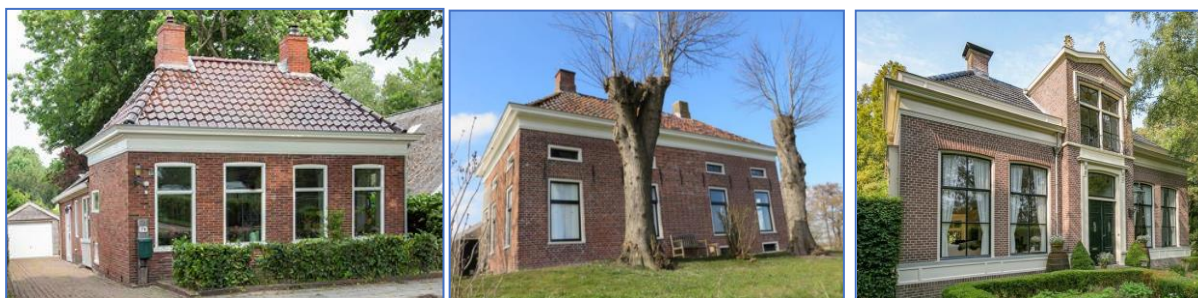
Figuren 72: Voorbeelden van in kalkmortel gemetselde kleine woningen met slechts één of anderhalve etage, waarbij het maken van een platform fundering al ongeveer even veel kost als de netto waarde van het gebouw.
