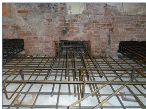
Figuren 1-83. Foto en schets van de aanleg van een platformfundering
