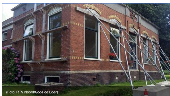
Figuren 1-48. Woning in de stutten met zijaanzicht en vooraanzicht.
