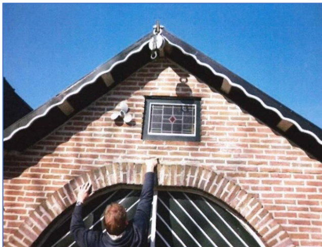
Figuur 1-46. Verwijdering van trekstangen in een garage.
