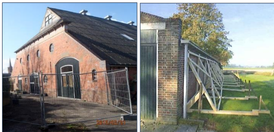
Figuren 1-79. Afzetten rondom een risicovolle gevelconstructie. De flexibele kap geeft geen steun (wel extra belasting) op de al grote massa van de hoge kopgevel. Rechts : Stutten van een oude slechte zijmuur.
