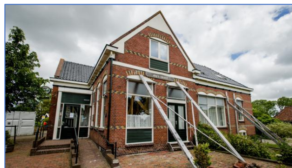
Figuren 1-98. Verschillende methoden van stutten worden toegepast.
