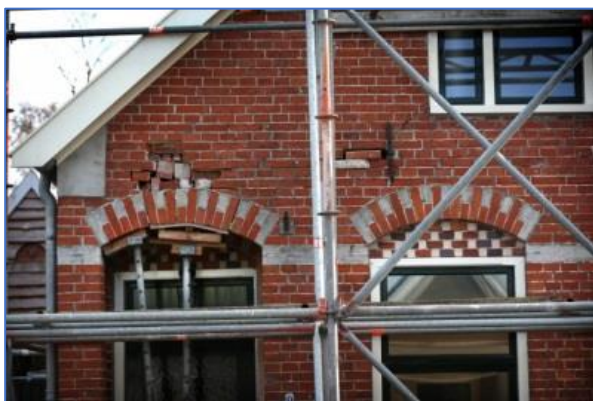
Figuren 1-98. Verschillende methoden van stutten worden toegepast.
