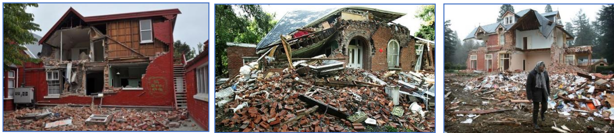
Figuren 1-60. Deze gebouwen zijn in de DS4 (net niet ingestort) en DS5 fase (ingestort), terwijl ze wel volgens de code seismisch bestendig waren gebouwd. Mw 6,2 en diepte slechts 5 km en een 15 km lange zone met PGAg \approx 0,22 verticaal en PGAg 0,17 horizontaal in het epicentrum. In de stad zelf waren de PGAg 0,08 verticaal en PGAg 0,07 horizontaal, vergelijkbaar met de 16-08-2012 Huizinge beving, maar dan veeeeeeel langer van duur.
