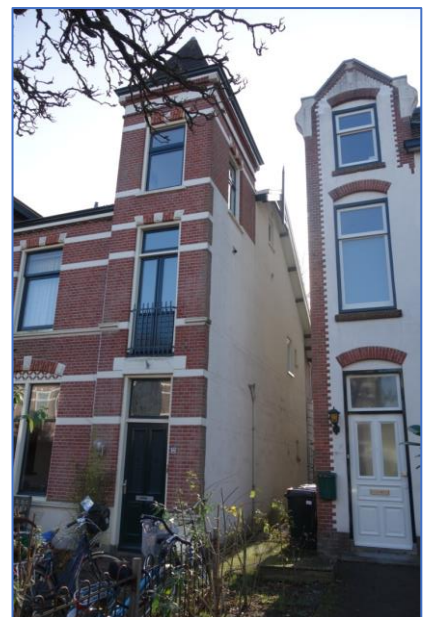
Figuur 36. Bij deze jaren-1900 woningen lopen de ruiten in de torentjes door tot vlak boven de etagevloer. In deze situatie moet een glasbedrijf adviseren om de binnenste ruit gelaagd te maken als doorvalbeveiliging.
