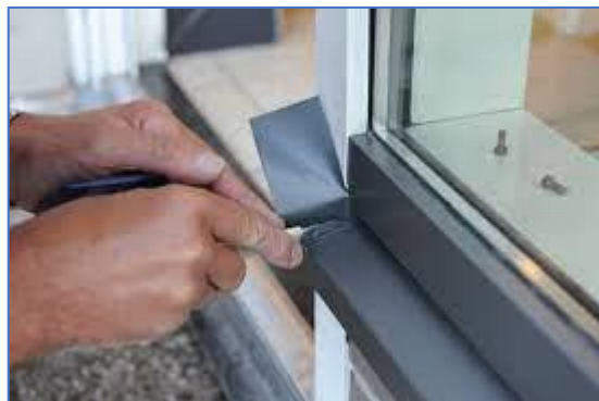
Figuur 24: Verweerde onderdorpels kunnen bekleed worden met een kunststof kozijnfolie in kleur als permanente bescherming.
