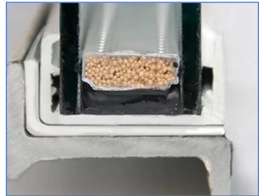
Figuren 11. Het Grona HR ++ isolatieglas kan in een bestaand stoeltjesprofiel kozijnen geplakt.
