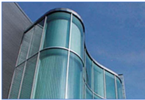
Figuren 48. Enkele voorbeelden van gebogen glas en gebogen HR^{++} glas.
