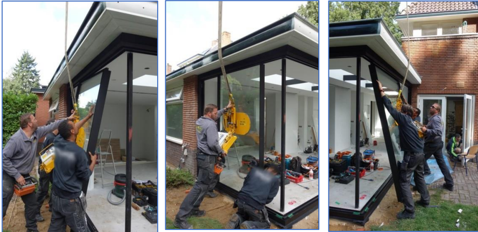
Figuren 32. Deze schuifdeur wordt in het kozijn geplaatst dat ongeveer 30 cm terug staat vanwege de dak overhang. Eerst wordt de bovenkant ingehaakt en dan met druk tegen de ruit de onderkant. Zuignap handvaten en grote schuifdeur. In deze situatie is glas met doorvalbeveiliging nodig.
