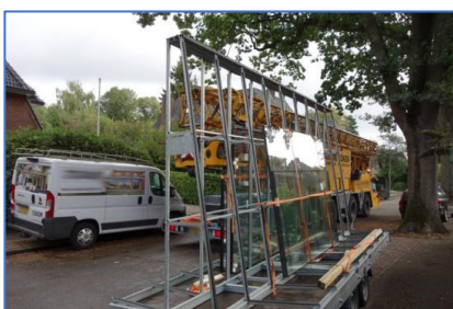
Figuren 32. Aanvoer glas of kozijn, vrij van geparkeerde auto's, zuignap met batterij, over het gebouw tillen.
