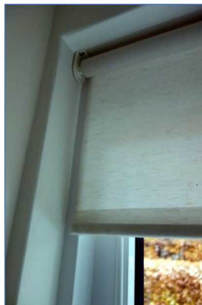
Figuur 26. Een nauw aansluitend rolgordijn 33 tegen het kozijn geeft een extra isolatiewaarde van ruim 0,15 \text{ m}^2\text{K/W} . De rol moet dan aan de kamerkant zitten. Met spouw >3 cm treedt luchtcirculatie (convector) op.
