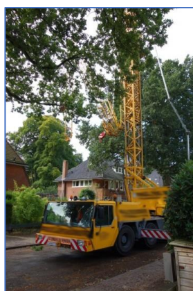
Figuren 32. Aanvoer glas of kozijn, vrij van geparkeerde auto's, zuignap met batterij, over het gebouw tillen.
