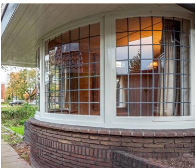
Figuren 48. Enkele voorbeelden van gebogen glas en gebogen HR^{++} glas.
