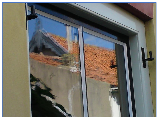
Figuur 12. Monumentaal glas heeft een licht gegolfd oppervlak dat geen vlakke reflectie veroorzaakt. Er zijn variaties met strepen en kleine belletjes in het glas.
