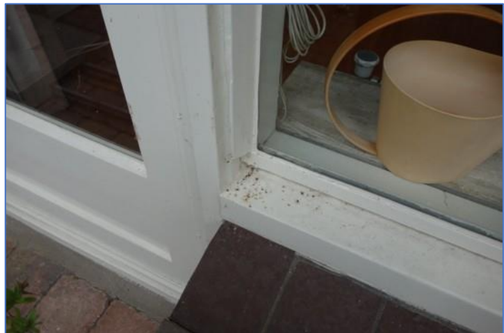
Figuur 20: In een dik kozijn kan de oude ruit en glaslat verwijderd worden voor de plaatsing van Tripleglas met de glaslat op het kozijn.
