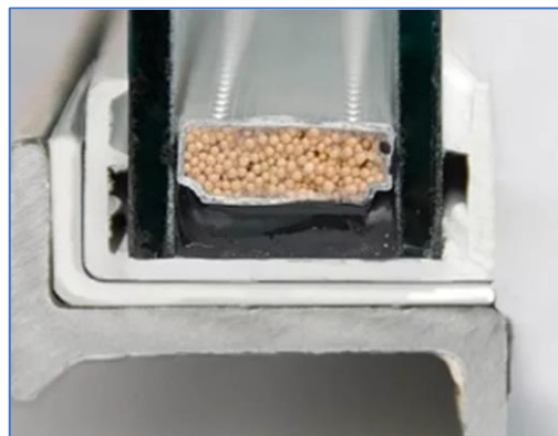
Figuren 13. Het Grona HR ++ isolatieglas kan in een bestaand stoeltjesprofiel kozijnen geplakt.
