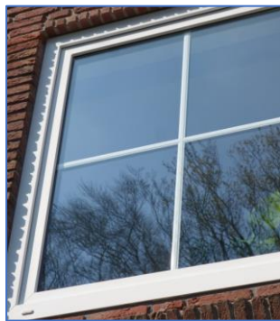
Midden: Wiener sprossen. Hier loopt het glas door, wat veel gunstiger is voor de gemiddelde isolatiewaarde van de hele ruit dan bij onderbreking van een spacer.
