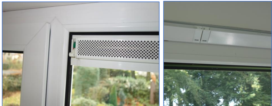
Figuren 25. Links : Duco rooster op de isolatieruit. Rechts : Duco rooster op het kozijn.
