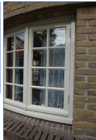
Midden: Wiener sprossen. Hier loopt het glas door, wat veel gunstiger is voor de gemiddelde isolatiewaarde van de hele ruit dan bij onderbreking van een spacer.
