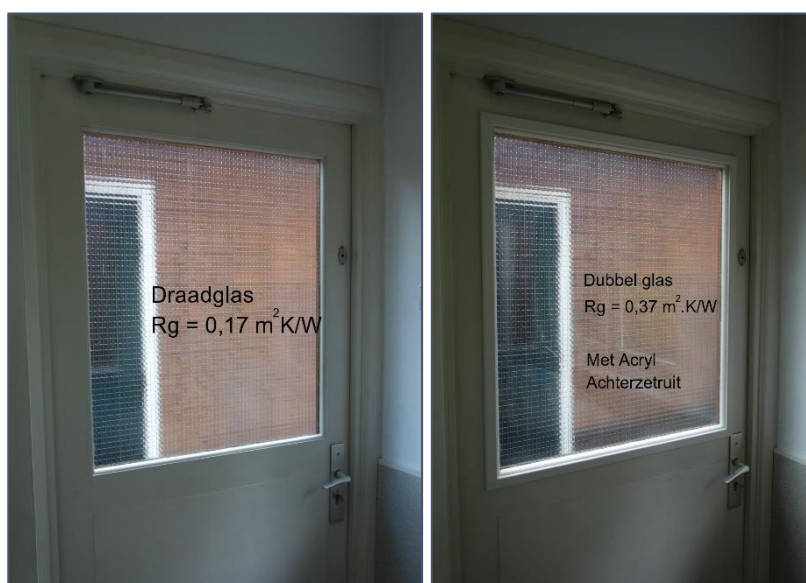
Figuren 2. Oude en nieuwe situatie. Toevoeging aan binnenzijde van heldere 2 mm Acrylplaat en luchtsponw van 18 mm. Afgewerkt met een hoeklat.
