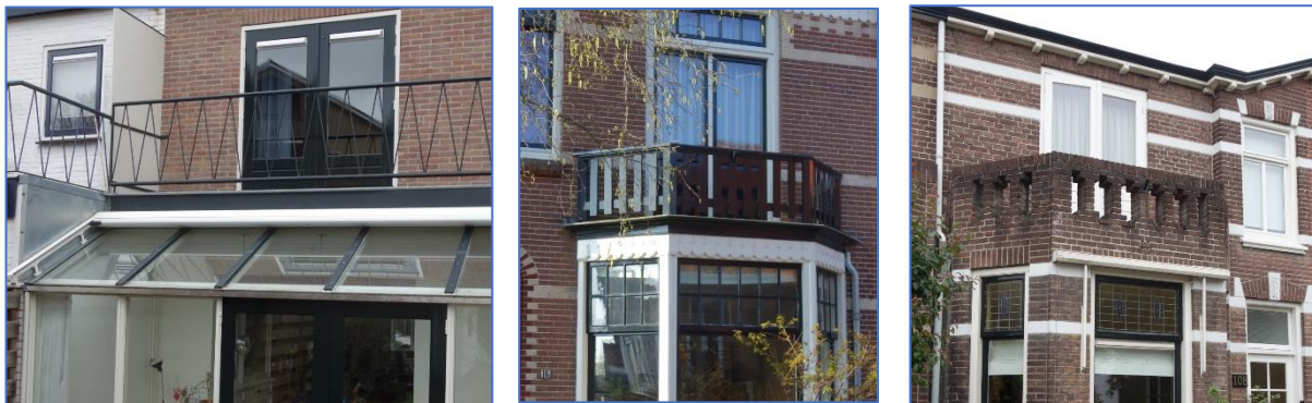
Figuren 2. Links : nieuwe aanbouw 1980; Midden: oude balkondeuren boven erker jaren 1890 woning; Rechts : gemetselde erkeropbouw met balkonleuning jaren 1910 woning.
