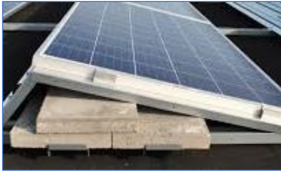
Figuren 18. Links: Eerste generatie verzaard met trottoirtegels. Rechtsboven: Een gesloten doos voorkomt dat er veel wind onder het paneel kan komen. Hierdoor kan de ballast kleiner zijn.
