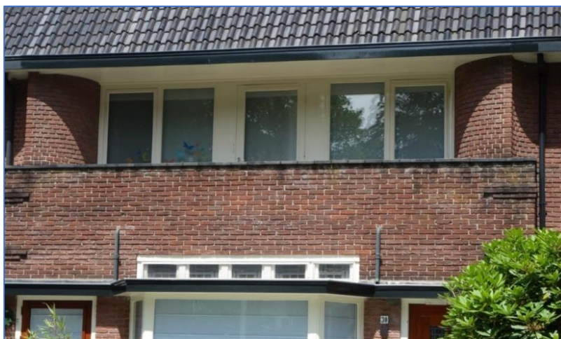
Figuren 9. Eerste etage met inpandig balkon en begane grond met erker met een gedeelte van het kozijn direct boven de zinken dakbedekking.
