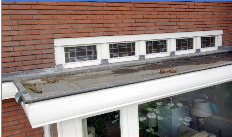
Figuur 10. Kleine glas-in-lood ruitjes in kozijn direct boven op de erker met een zinken dakafwerking.
