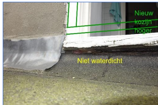
Figuren 15. Nieuw bitumen dakafwerking, maar niet doorgezet onder oude dorpel. Bij verstopping afvoer ontstaat lekkage.
