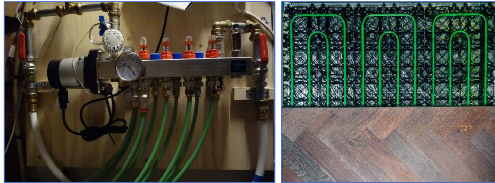
Figuren 15. Dun 10 mm LTV- vloerverwarming leidingensysteem van Warp met vier groepen. Afwerking met dun laminaat.
