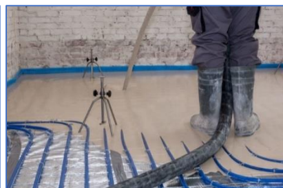
Figuren 33. Links : I betonbalkjes op aangestorte funderingsrand. Midden : beton druklaag met wapeningsnet. Rechts : Natte afwerking met anhydriet gietlaag waar de LTV-vloerverwarming in zit.
