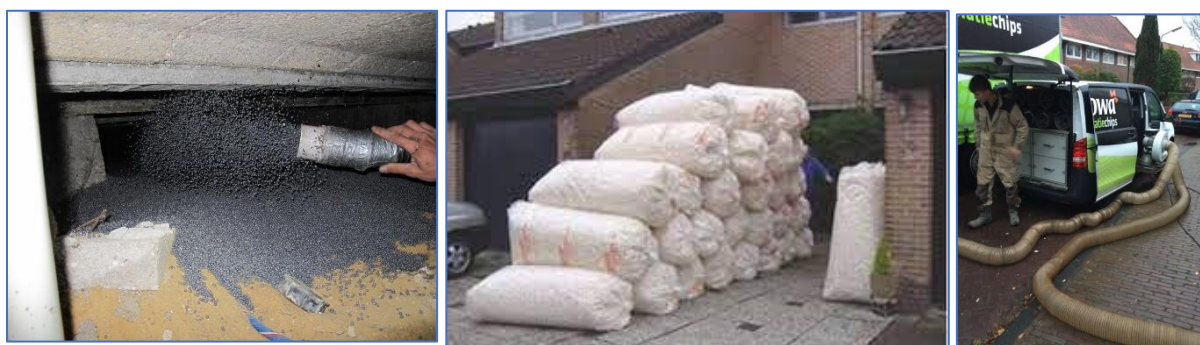
Figuren 28. Links : EPS-korrels of parels volblazen.
