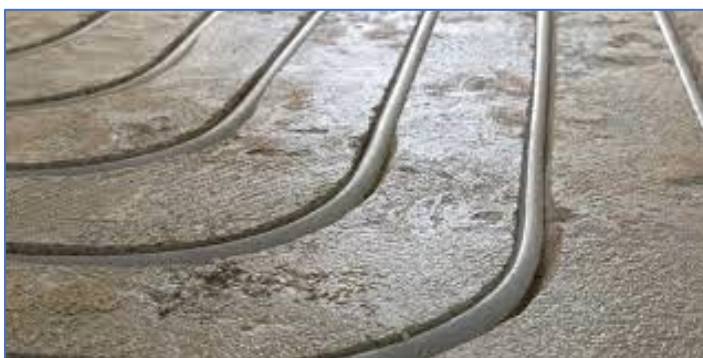
Figuren 17. Boven . Infresen van toplaag betonnen vloer. Rechts Leidingen geplaatst.
