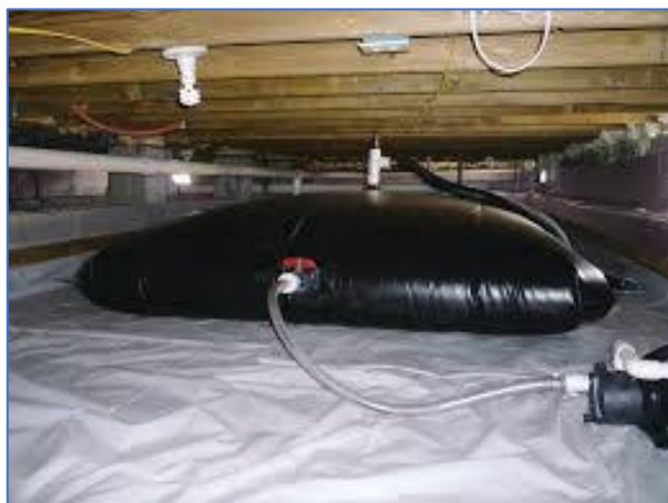
Figuren 39. Waterbuffer of regenwateropslag in hoge kruipruimte. De filter en pomp apparatuur neemt ook ruimte in. In aanvulling zijn er extra leidingen nodig (afbeelding links).
