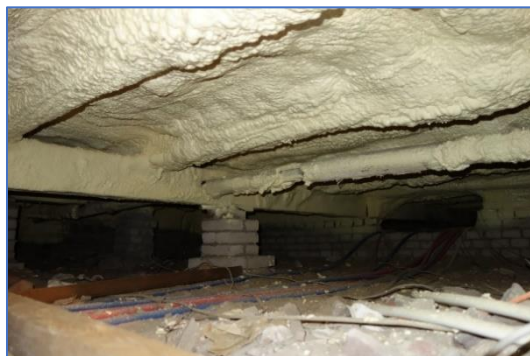
Figuren 25. Het aan de onderkant isoleren van betonnen systeemvloeren kan met PU-foam (niet aanbevolen vanwege milieutechnisch onaanvaardbaar ) of met glaswoldekens die met glaswol-paraplu-plakkers worden vastgehouden. Dit kan ook met Doe Het Zelf (DHZ).
