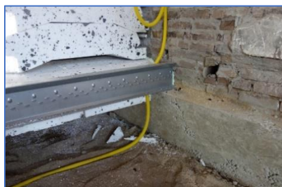
Figuren 33. Links : I betonbalkjes op aangestorte funderingsrand. Midden : beton druklaag met wapeningsnet. Rechts : Natte afwerking met anhydriet gietlaag waar de LTV-vloerverwarming in zit.
