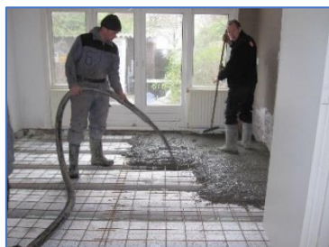
Figuren 33. Links : I betonbalkjes op aangestorte funderingsrand. Midden : beton druklaag met wapeningsnet. Rechts : Natte afwerking met anhydriet gietlaag waar de LTV-vloerverwarming in zit.
