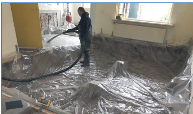
Figuren 30. Schuimbeton en afwerking. Bovenop komt isolatie en de LTV-vloerverwarming. De schuimbeton vloer draagt geheel op de onderliggende grond en belast niet de fundering van de woning.
