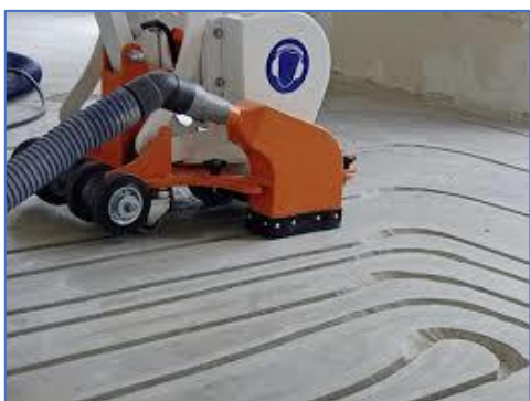
Figuren 17. Boven . Infresen van toplaag betonnen vloer. Rechts Leidingen geplaatst.
