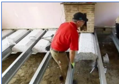
Figuren 32. Links : I betonbalkjes. Midden : dunmetalene I-profielen. Rechts : Dunmetalene I kokerprofielen die op maat geleverd of gezaagd worden.
