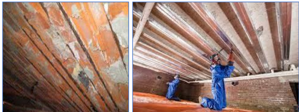
Figuren 23. Links: Nehobo vloer met corrosie van de wapening.
