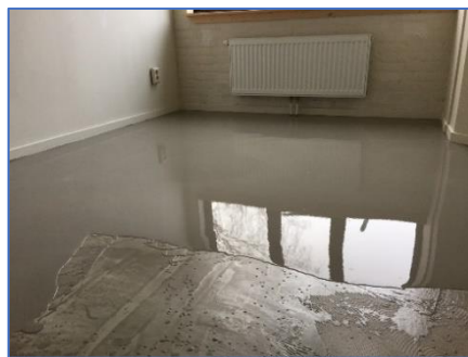
Figuren 18. Boven . Afsmeren gelegde leidingen. Rechts . Eventueel egaliserende Anhydriet vloelaag.
