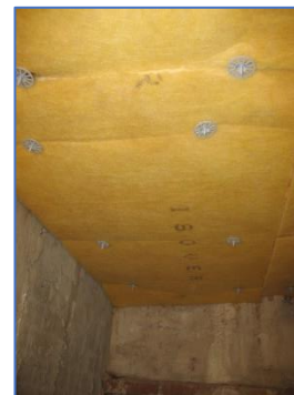
Figuren 25. Het aan de onderkant isoleren van betonnen systeemvloeren kan met PU-foam (niet aanbevolen vanwege milieutechnisch onaanvaardbaar ) of met glaswoldekens die met glaswol-paraplu-plakkers worden vastgehouden. Dit kan ook met Doe Het Zelf (DHZ).
