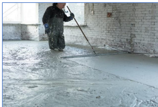
Figuren 30. Schuimbeton en afwerking. Bovenop komt isolatie en de LTV-vloerverwarming. De schuimbeton vloer draagt geheel op de onderliggende grond en belast niet de fundering van de woning.
