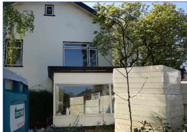
Figuur 24: PIR-isolatiemateriaal voor het binnenzijdig na-isoleren van alle buitenmuren van een ruime woning met steensmuur in een beschermd stads/dorpsgezicht. Het toegevoegde volumen is meer dan de inhoud van een kleine slaapkamer.
