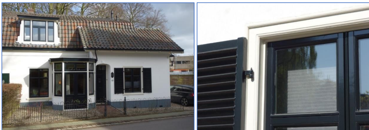
Figuren 18: De rechterkant van deze kleine hoekwoning werd buitenzijdig geïsoleerd met 4 cm Recticel.
