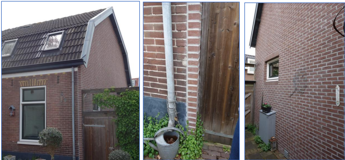
Figuren 19. Links: De zijgevel werd hier na-geïsoleerd. Kleur overeenkomst is goed te bereiken. Midden: Slechts van dichtbij is te zien dat er een laagdikte verschil is met de oude gevel uit 1925. Wanneer de regenpijp voor de naad had gezeten was het nog minder opgevallen. Rechts: Gedeelte van de zijgevel, \approx 40\text{m}^2 .
