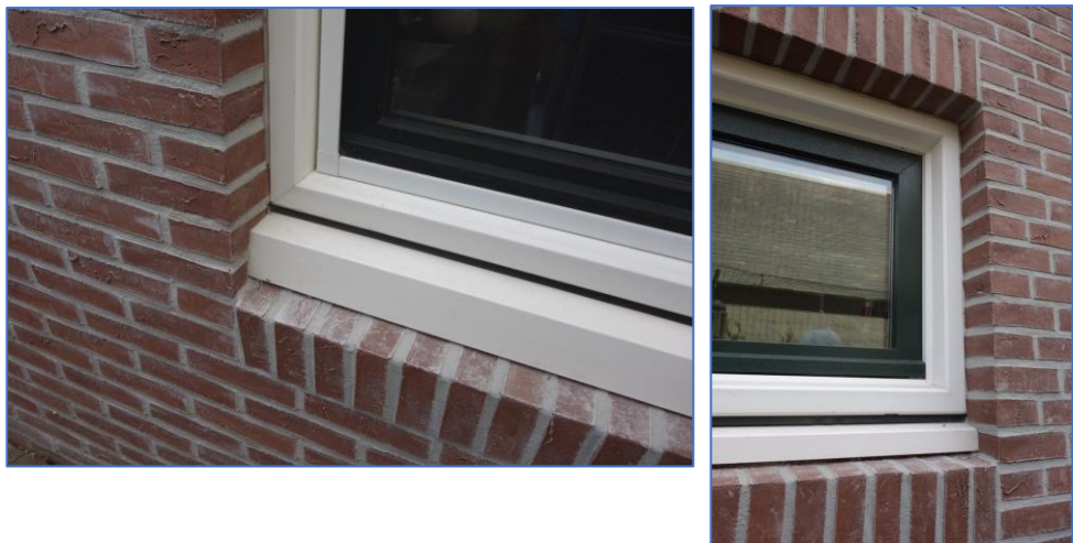
Figuren 19. Links: De zijgevel werd hier na-geïsoleerd. Kleur overeenkomst is goed te bereiken. Midden: Slechts van dichtbij is te zien dat er een laagdikte verschil is met de oude gevel uit 1925. Wanneer de regenpijp voor de naad had gezeten was het nog minder opgevallen. Rechts: Gedeelte van de zijgevel, \approx 40\text{m}^2 .
