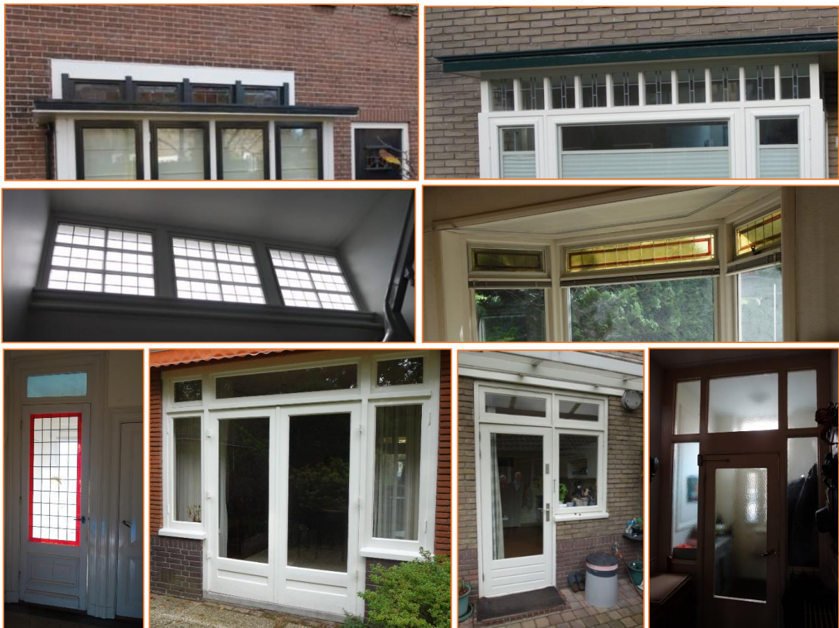
Figuren 1. Vooral oudere woningen (jaren 1900-1930) hebben veelvuldig bovenlichten in de gevel of vestibule.
