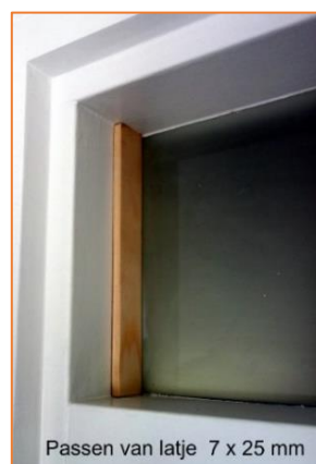
Figuren 4. Maak voor de twee zijanten het latje 7 mm x 25 mm op maat en schilder het in de kleur van het kozijn. Plak (de volgende dag) op 2 kanten van het latje tweezijdig plakband.
