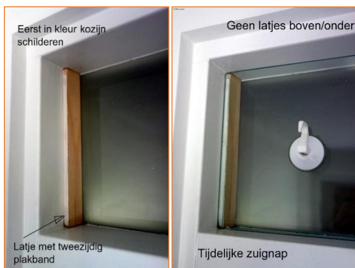
Figuren 5. De smalle 10 mm dubbelzijdige transparante tape is het meest praktisch. Voor de foto's is de witte tape gebruikt om het zichtbaar te houden.
