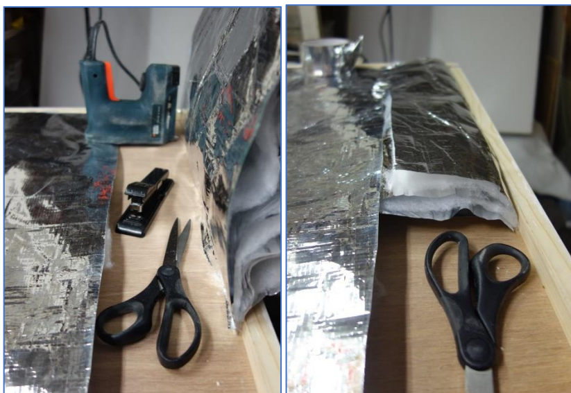
Figuren 11. Met een stapel-machine wordt de multifolie tegen de rand vastgeniet. Afhankelijk van de dikte kunnen additionele folies en spouwvulling worden toegevoegd.
