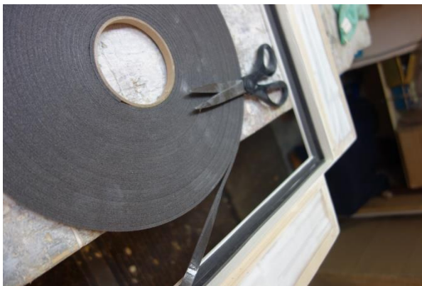
Figuren 15. Links: Invulling met twee lagen Bluedec stroken. Daarna de houten randen goed schoonvegen en de rand dichtplakken met breed verpakking cellotape (tegen het stof van de Bluedec). Rechtsboven: Gebruik bij het afhalen van de ruit rubberhandschoenen en schuur de acht randen van het glas zodat het geen scherpe randen heeft. Rechts: Het glasband wordt in de sponning gelegd.
