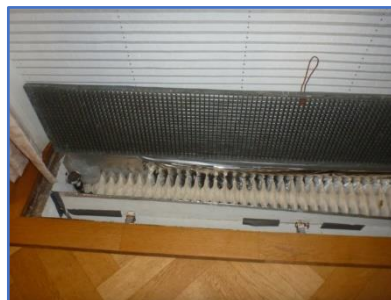
Figuren 8. Het houten rooster met de meeste opening verbetert de lucht circulatie.
