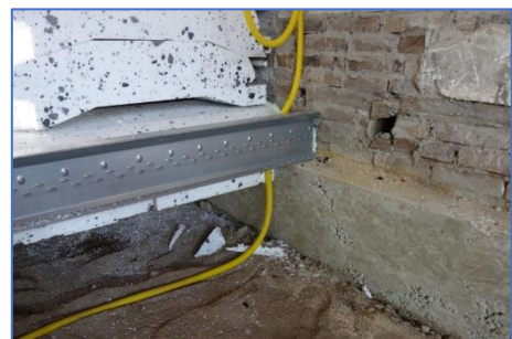
Figuur 11. Jaren-30 woning zonder woonkamervloer. Betonnen draagstrook langs de fundering met stalen \perp balken met EPS broodjes/blokken. Daarover komt een druklaag en de LTV.
