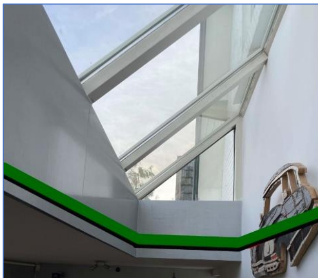
Figuren 27. Links: Dubbelwandige heldere Polycarbonaat kanaalplaat 16 mm dik heeft 4 luchtkamers en een R_c = 0,5 en lichtdoorlaat 85%. Rechts: Onder een lichtstraat op de volle zon kan een dragende rand gemaakt worden (zwarte lijn) waar de holle Polycarbonaatplaat (groene lijn) op wordt gelegd.
