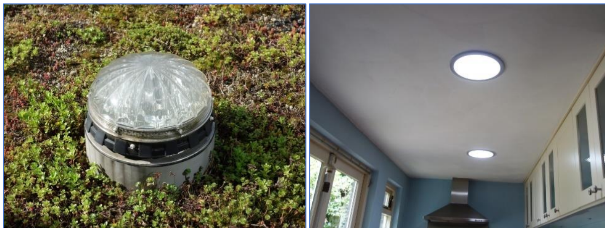
Figuren 10. Links . Solatube tussen Sedum, op een plat dak en van binnen gezien in de keuken. Rechts . Er zijn modellen waarbij aan de binnenzijde een sterke LED-lamp is ingebouwd voor goede verlichting 's nachts. Solartubes kunnen ook vanaf de bovenliggende etage naar de onderste etage lopen voor verlichting.
