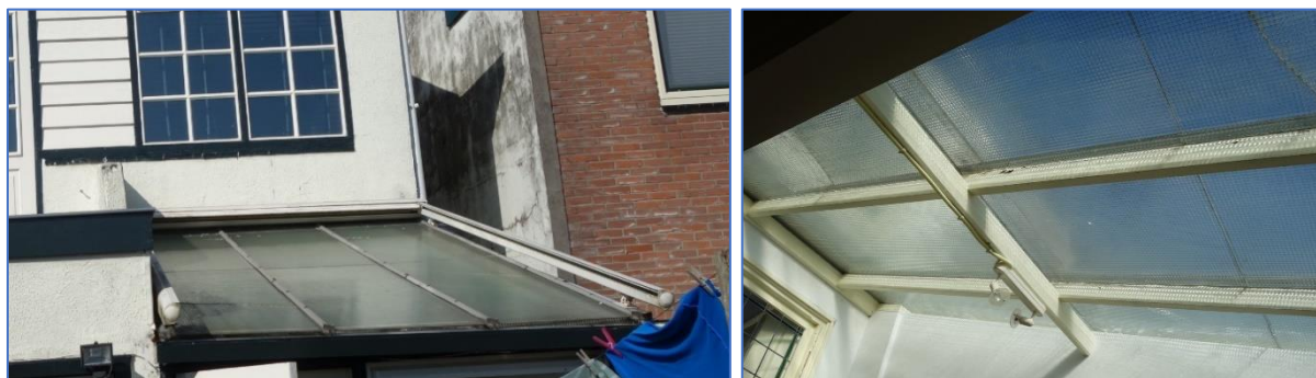
Figuren 7. Bij deze oudere woning is een draadglas (doorgezakt) dakraam op de uitbouw. De constructie is te zwak om er een andere ruit in te zetten. In deze situatie is het beter om het vaste dak links door te trekken zodat er een doorlopend en goed geïsoleerd dak ontstaat. In dat dak kan dan een kleine, maar goed geïsoleerde lichtstraat geplaatst worden of enkele Solartubes.
