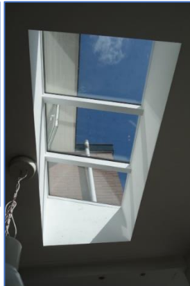
Figuren 26. Bij oudere HR ruiten wordt de nieuwe isolatiewaarde bij een extra goede kwaliteit HR ++ ruit R_c \approx 1,45 \text{ m}^2 \cdot \text{K}/\text{W} .
