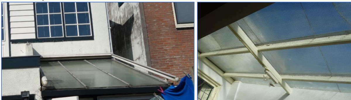
Figuren 7. Bij deze oudere woning is een draadglas (doorgezakt) dakraam op de uitbouw. In deze situatie is het beter om het vaste dak links door te trekken en een kleine, maar goed geïsoleerde lichtstraat te plaatsen.
