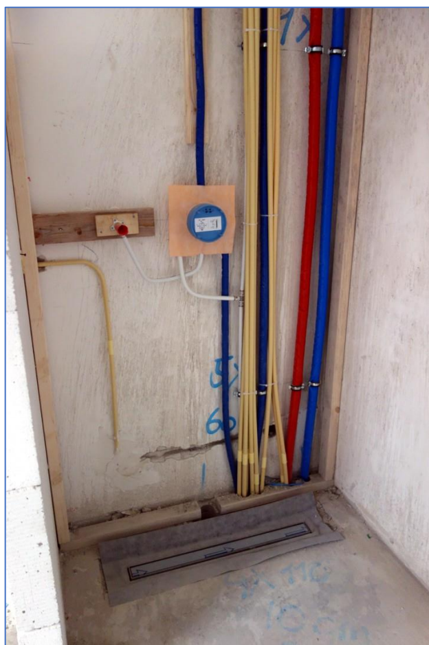
Figuren 1. Links . Doorsnede WTW-rioolbuis. Het afvoerwater loopt altijd langs de hele wand. Rechts . Aanleg van de douche afvoer met achter de douche wand verschillende leidingen voor elektra en de Cv (rood en blauw). Bij deze reconstructie zit de verticale WTW van de douche op de etage eronder. Het blauwe rondje is de positie van de mengkraan met de kunststof (PEX) leidingen. Het rode puntje links daarvan is de uitgang van de warmwaterleiding.
