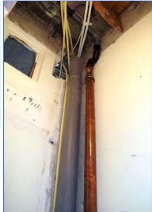
Figuren 2. Links . Aansluiting van de WTW pijp op de riolering. Midden . De aansluiting van de waterleiding. Rechts . Een woning waarbij in de traphoek de verticale WTW langs de rioleringsleiding loopt.
