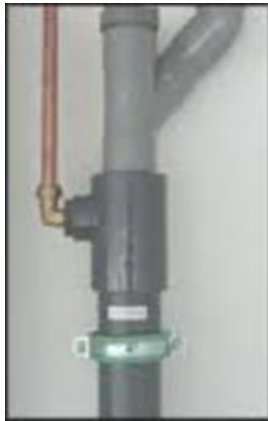
Figuren 2. Links . Aansluiting van de WTW pijp op de riolering. Midden . De aansluiting van de waterleiding. Rechts . Een woning waarbij in de traphoek de verticale WTW langs de rioleringsleiding loopt.
