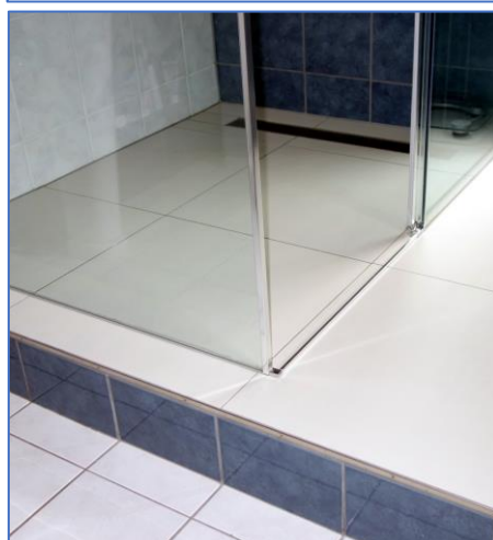
Figuren 8. Verschillende constructies van de goot met de wateraansluitingen. Hoe minder de metalen bak van de goot de warmte van het douchewater opneemt hoe economischer het systeem werkt.
