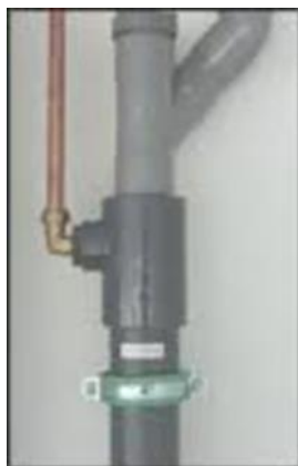
Figuren 4. Links . Aansluiting van de WTW pijp op de riolering. Midden . De aansluiting van de koudwaterleiding. Rechts . Een woning waarbij in de traphoek de verticale WTW langs de rioleringsleiding loopt.
