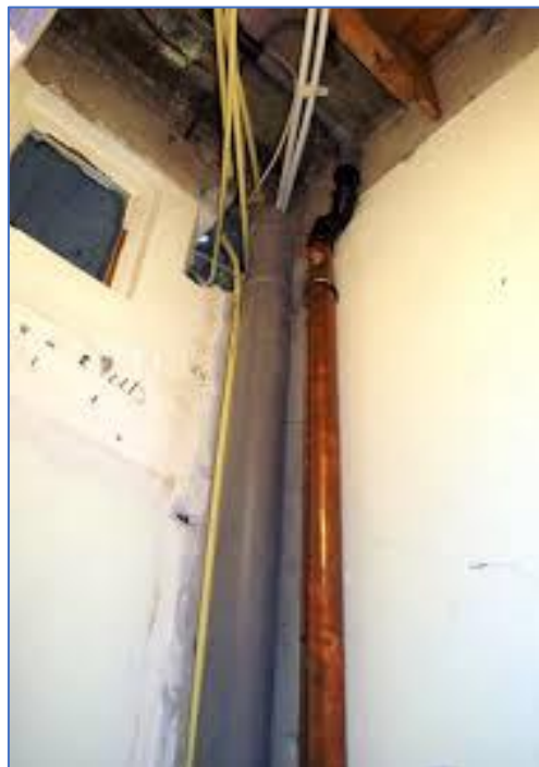
Figuren 4. Links . Aansluiting van de WTW pijp op de riolering. Midden . De aansluiting van de koudwaterleiding. Rechts . Een woning waarbij in de traphoek de verticale WTW langs de rioleringsleiding loopt.
