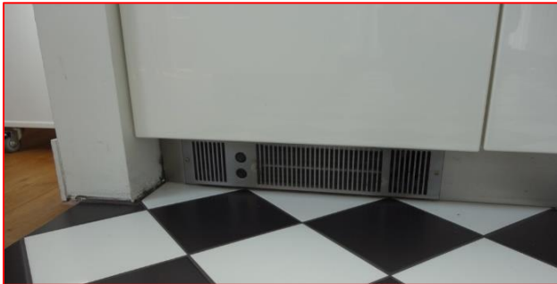
Figuren 27. Plintverwarming in de keuken. Wanneer deze onder de koelkast wordt geplaatst verwarmt deze de koelkast en verstoort het de luchtcirculatie. Allebei verkeerde maatregelen.
