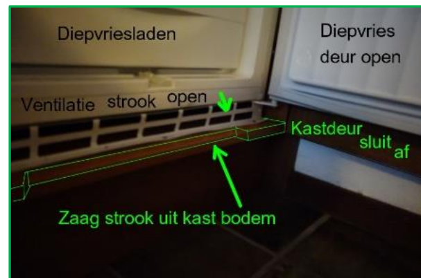
Figuren 10. Links . Bestaand. Rechts . Door een strook uit de voorkant bodem van de keukenkast te zagen (eenvoudig) wordt er een opening van >200 \text{ cm}^2 gemaakt en kan de ventilatielucht er langs de plint van onderen achter de deur langs omhoog en dan door het rooster onder langs en achter de koelkast naar boven.
