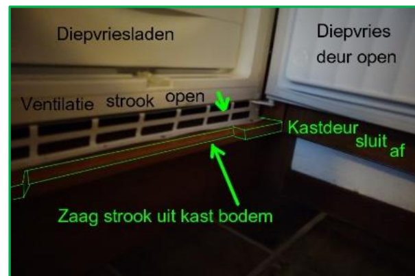
Figuren 8. Links . Bestaand. Rechts . Door een strook uit de voorkant bodem van de keukenkast te zagen (eenvoudig) wordt er een opening van >200 cm 2 gemaakt en kan de ventilatielucht er langs de plint van onderen achter de deur langs omhoog en dan door het rooster onder langs en achter de koelkast naar boven.
