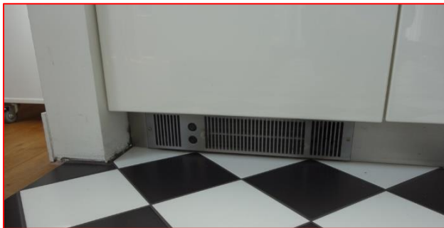
Figuren 25. Plintverwarming in de keuken. Wanneer deze onder de koelkast wordt geplaatst verwarmt deze de koelkast en verstoort het de luchtcirculatie. Allebei verkeerde maatregelen.
