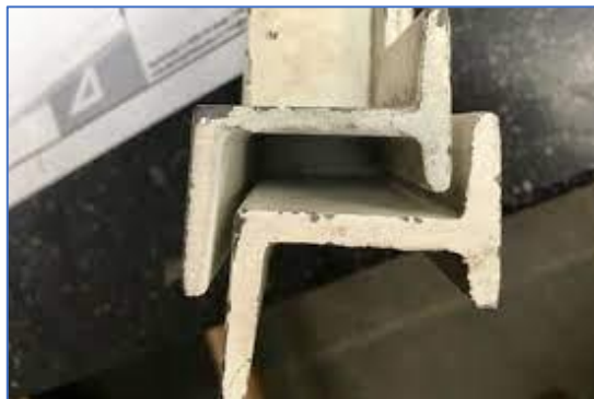
Afbeeldingen 14. Het duurzaam roestbestendig maken van stalen stoeltjes profielen ramen en kozijnen vereist nauwkeurig werk. De ramen, deuren en kozijnen van ijzeren stoeltjes profielen hebben een erg slechte isolatie van R_c \approx 0,17 \text{ m}^2 \cdot \text{K/W} (inclusief de twee overgangswaarden), dus niet beter dan enkel glas.
