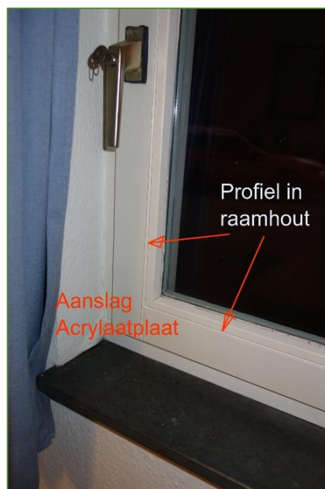
Afbeeldingen 40. In sommige houten ramen zit een profiel van 2 mm. Deze dikte is precies genoeg voor een 2 mm Acrylaatplaat. In die sponning wordt dan een transparant tweezijdig plakband geplakt en de plaat er tegenaan gedrukt. Hierdoor wordt een luchtsponw van 18 mm - 20 mm gecreëerd. Duurzame en goedkope oplossing.
