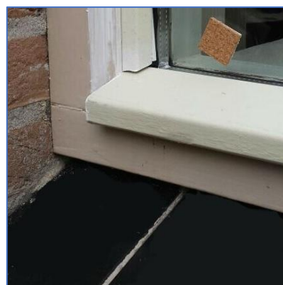
Afbeeldingen 11. Links : Afwatering tussen raam en kozijn. Raam vast met triple glas. Raam eruit en optimaal Triple glas direct in het kozijn. Rechts : Neuslat met overhang en ruimte onder de waterslag dorpel. In deze foto is het kozijn met de glaslaten nog niet afgeschilderd. Dat kan pas als de glas-mastiek goed is uitgehard.
