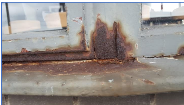
Afbeeldingen 14. Het duurzaam roestbestendig maken van stalen stoeltjes profielen ramen en kozijnen vereist nauwkeurig werk. De ramen, deuren en kozijnen van ijzeren stoeltjes profielen hebben een erg slechte isolatie van R_c \approx 0,17 \text{ m}^2 \cdot \text{K/W} (inclusief de twee overgangswaarden), dus niet beter dan enkel glas.
