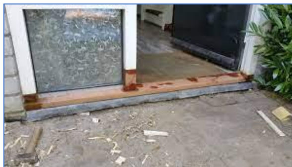
Afbeeldingen 33. Slechte onderdorpels kunnen goed vervangen worden met hardhouten of Accoya (thermisch verduurzaamd) inzetstukken en twee-componenten epoxy pasta's en lijm.
