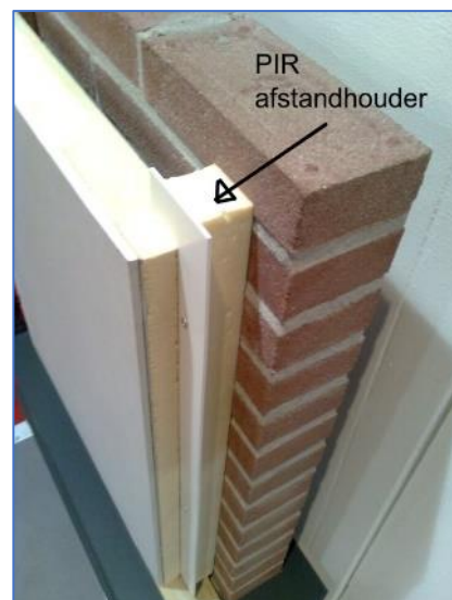
Figuren 26. Oplossing met PIR-stroken tegen de baksteen gevel. Wanneer de spouw (> 2 cm) tussen de muur en het isolatiemateriaal een HRF2- folie heeft is dit een uitstekende oplossing.
