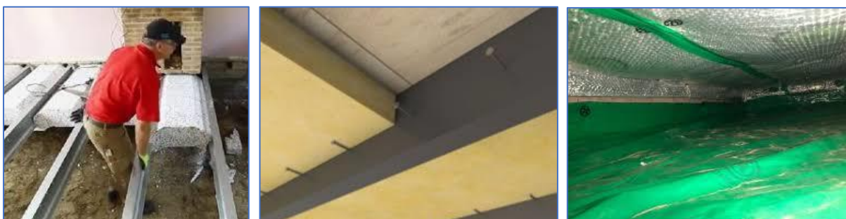
Figuren 7. Bij begane grondvloer isolatie is het effect van gebrek aan isolatie op of onder de balken minder omdat het temperatuurverschil met de bodem hier minder is dan buiten bij de gevel of het dak.
