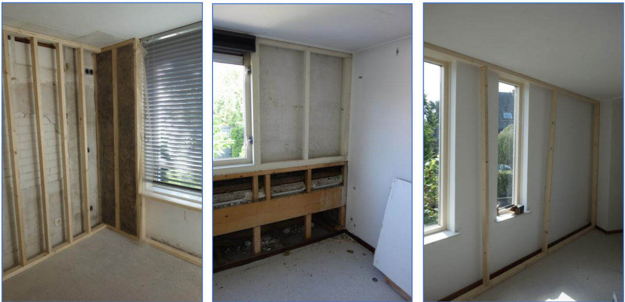
Figuren 16. Binnenzijdige muurisolatie met houten regels en bruine glaswol. Omdat hier een glaswolisolatie is toegepast op een enigszins geïsoleerde spouwmuur (bouwjaar 1987 met R_c = 2,0 ) met een glaswol isolatiewaarde van R_c = 2,7 is een binnenzijdig toegevoegde dikte van minimaal 10 cm nodig. Wanneer de glaswoldeken ook achter de houten regels is toegepast worden lange warmtelekken voorkomen. Aan de binnenzijde (warme zijde) moet een dampdichte folie worden toegepast.
