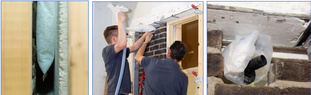
Figuren 23. Vacuüm isolatiezakken in dunne spouw. Oneffenheden mogen de zakken niet kunnen beschadigen.
