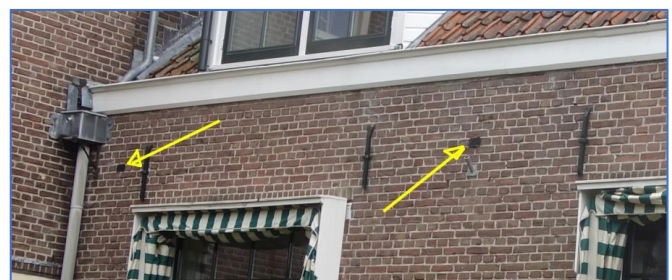
Figuur 4. Bij deze oudere woning met steensmuur, afwisselende lagen met koppen en strekken, zitten tussen de balkankers kleine ventilatieopeningen. Hier kan het zijn dat tussen de balklaag of de binnen achterzetwand een klein beetje ventilatie is.
