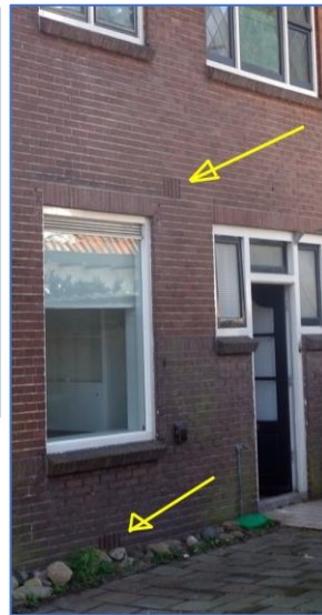
Figuren 1. Links : dichtgeslibd ventilatierooster van de spouw. Midden : goede spouw ventilatie onder en boven. Rechts : binnen ventilatie bij een kelder.
