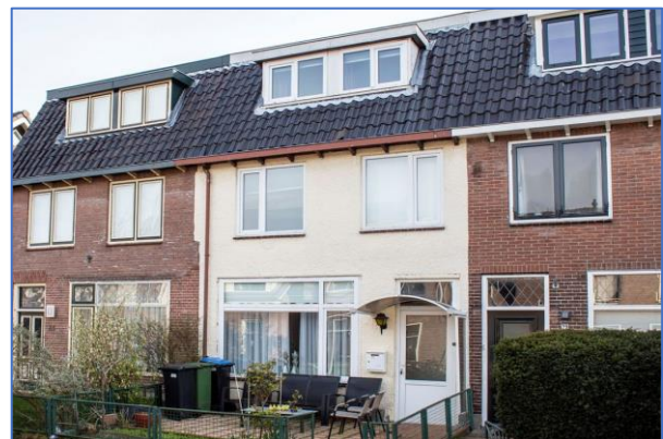
Figuur 20. Niet alleen de voorkant, maar ook de achterzijde kan geschilderd zijn. Vaak is een tuinzijde aanbouw geschilderd. Wanneer het een damp-open verf is dan is spouwmuur na-isolatie wel mogelijk. Bij dampdichte verf kunnen vochtproblemen ontstaan.
