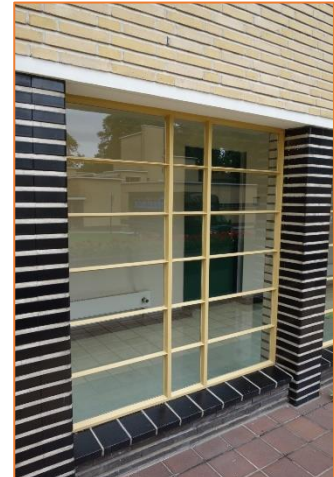
Figuren 6. Langs de hele binnenplaats en gangen bevinden zich vaste raampartijen die eenvoudig voorzien kunnen worden van Acrylplaten. Boven in de gangen is de toepassing van dubbele Acrylplaten probleemloos toe te passen; deze ramen zijn slechts voor de lichtinval en zijn buiten het zicht.
