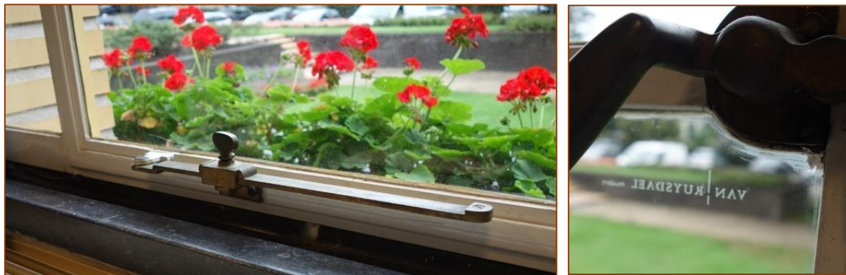
Figuren 14. Handvat van het openzetbare raam. Rond het handvat zal een achterzetruit van onbreekbaar Polycarbonaat plaat nauw moeten aansluiten. Het maken van inkepingen in Acrylplaat zal barsten veroorzaken.
