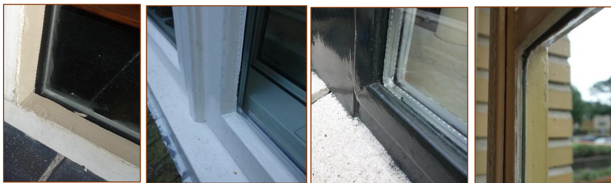
Met zwarte afstand TGI ; Met houten opdeklat. 4-4Argon-:4 Rg = 0,60 ; 4-6Argon-:4 Rg = 0,60 ; 4-12Argon-:4 Rg = 0,65 ; Vacuüm 6,5 mm Rg = 1,43
