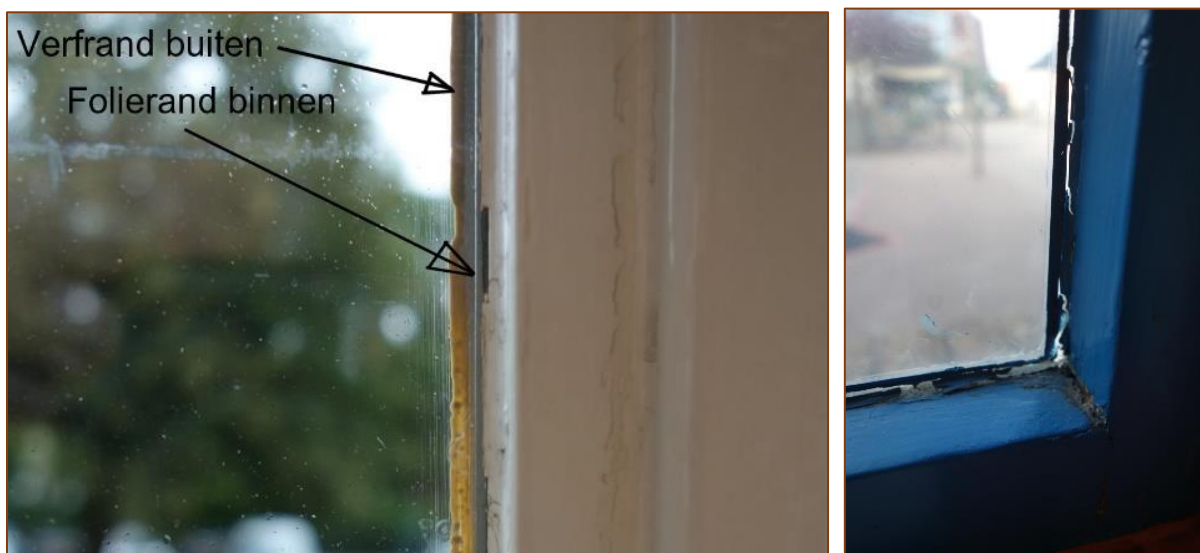
Figuren 11. 3M-folie op binnenzijde geplakt. Rechts bij een blauw geschilderd houten raam. In beide voorbeelden is de afwerking niet erg fraai. Het geeft aan dat veel ervaring nodig is om de folie aan te brengen en dat naderhand het verfwerk van het raamwerk op het glas goed moet worden uitgevoerd.
