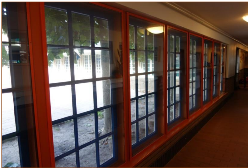
Figuren 12. Gang van schoolgebouw met binnenzijdige Acrylaat platen. Omdat de afsluiting niet voldoende dicht was kwam er condensatie vocht tussen de ramen en op het blauw geschilderde houtwerk. Vanwege slecht verfwerk drong het vocht in het hout en veroorzaakte rot. Het goed vocht dicht binnenzijdig schilderen van oude houten kozijnen is essentieel om ze tegen vocht aantasting te beschermen.
