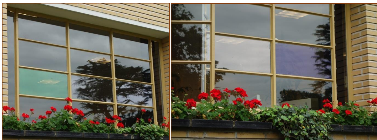
Figuren 2. Links : Monuglas® Modern 8 gelamineerd, groen; Ruysdael VR12.05 binnenfolie; 3M-Thinsulate film; Rechts : Monuglas® Modern 9 met 3 mm Krypton spouw, wit; AGC-Fineo Vacuüm glas 6,5 mm, paarsig.
