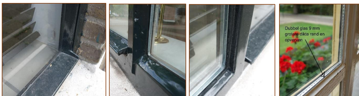
Figuren 16. Dun isolatieglas in stalen ramen. Specificatie van buiten naar binnen. : = low-e coating Enkel glas 3 mm Rg = 0,17 ; 4-3Argon-:4 Rg = 0,30 ; 4-4Argon -:4 Rg = 0,4 ; 3-3Krypton-:3 Rg = 0,5
