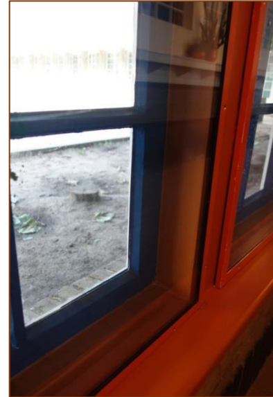
Figuren 12. Gang van schoolgebouw met binnenzijdige Acrylaat platen. Omdat de afsluiting niet voldoende dicht was kwam er condensatie vocht tussen de ramen en op het blauw geschilderde houtwerk. Vanwege slecht verfwerk drong het vocht in het hout en veroorzaakte rot. Het goed vocht dicht binnenzijdig schilderen van oude houten kozijnen is essentieel om ze tegen vocht aantasting te beschermen.
