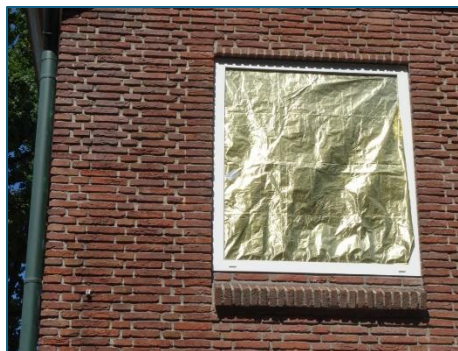
Rechts. Aan de binnenkant toegepaste radiatorfolie. De hoge lichtreflectie zorgt ervoor dat de warmte beperkt binnenkomt. Goedkoop en effectief.
