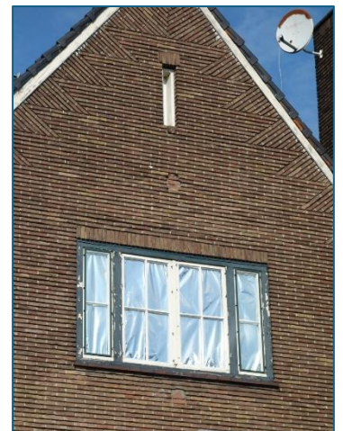
Rechts. Aan de binnenkant toegepaste radiatorfolie. De hoge lichtreflectie zorgt ervoor dat de warmte beperkt binnenkomt. Goedkoop en effectief.
