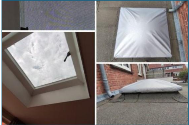
Figuren 12. Door de toepassing van gemetalliseerd doek wordt het meeste licht teruggekaatst, maar laat gedurende de zonuren wel voldoende licht binnen. Links: Goedlicht. Rechts: Serge Ferrari Soltis 86 Alu Alu.
