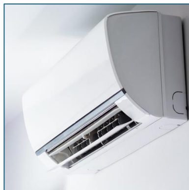
Figuren 25. Binnen airco vlak tegen het plafond en (Rechts) lekwater uit de buitenunit (waarschijnlijk in de binnenunit ontstaan en via een afvoerleiding (op afschot) naar buiten getransporteerd).
