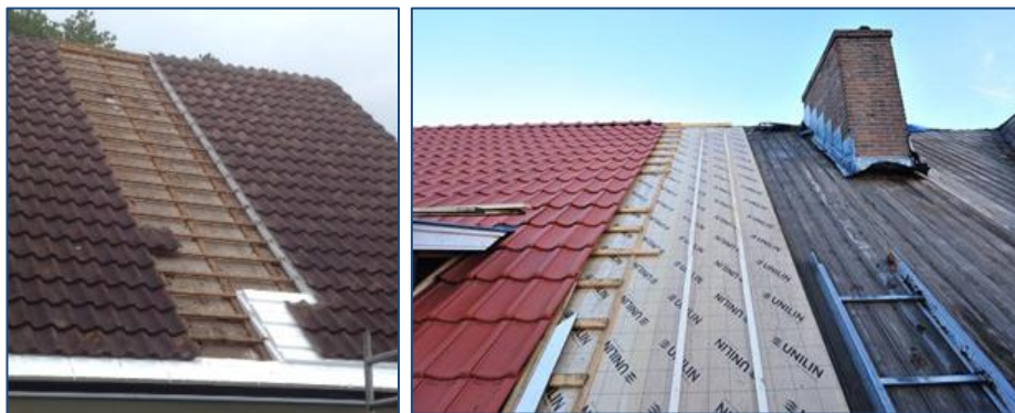
Figuren 9. Methode a) met het verwijderen en na isoleren terugplaatsen van dezelfde dakpannen. Rechts met nieuwe panlatten en dakpannen.
