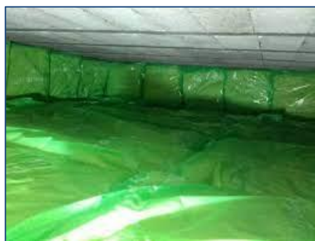
Figuren 20. Bodemisolatie met isolatie dekens met EPS-vulling en bij een hoge kruipruimte tegen de fundering opgezet.
