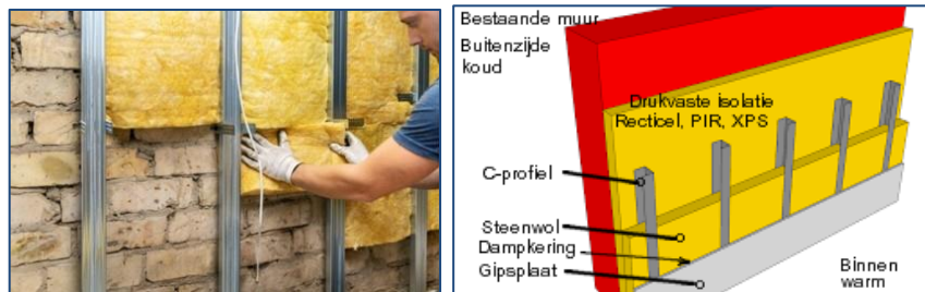
Figuren 30. Metalen studs creëren lange warmtelekken in de isolatie (is fout). Een isolatieplaat van (Bluedec, PIR, Recticel) erachter voorkomt dit.
