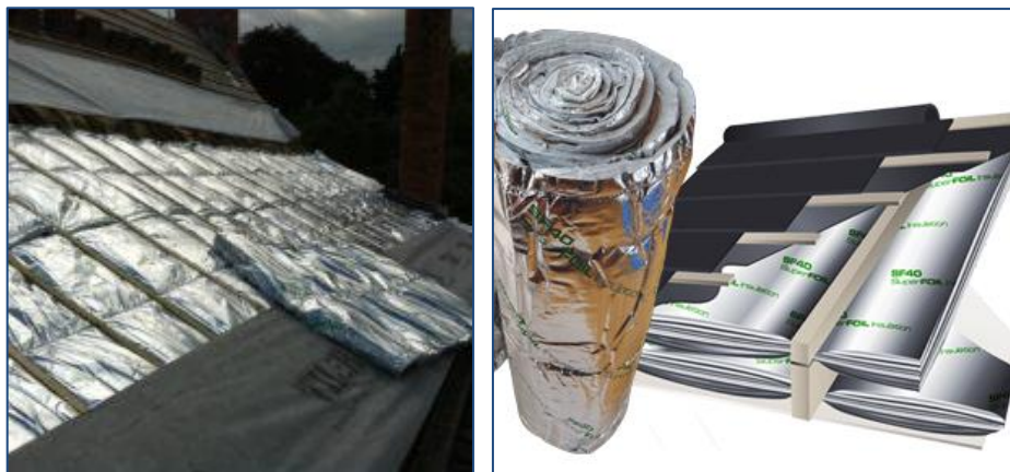
Figuren 10. Methode b). Links : De multi-folie wordt onder de regels of panlatten vastgezet, daar vermindert de isolatiewaarde sterk. Rechts : De verhoogde regels geven een betere isolatie dan links, maar ook lange warmtelekken. De binnenzijde moet dampdicht zijn en de buitenzijde regenwater doorlekvrij en dampopen.
