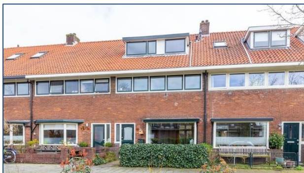
Figuren 4. Bij dakkapellen die doorlopen bij de burens is het aan te bevelen om de hele rij tegelijkertijd goed te isoleren en van nieuwe dakbedekking te voorzien. Rechts . Bij rijtjeswoningen waar zowel dakkapellen als erkers kleine platte daken hebben, is het uitvoeren van meerdere daken tegelijkertijd financieel voordeliger. Bij alle oude woningen is de isolatie van deze gebouwonderdelen zeer slecht.
