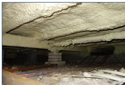
Figuur 18. Goede isolerende werking, maar na het aanbrengen moet de woning voor gedurende een week goed geventileerd worden om de drijfgassen te verwijderen. Tegenwoordig zijn de drijfgassen milieuvriendelijk.
