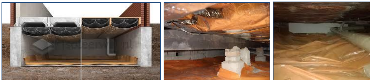
Figuren 17. Links : Tonzon thermokussens onder betonnen vloer en tussen en onder houten vloer, met een dekzeil op de grond. Het dekzeil maakt het werken makkelijker en verminderd Radongas uit de bodem. De kruipruimte moet altijd iets geventileerd blijven. Midden : Tonzon onder houten vloer die op een onderslagbalk draagt. Rechts : in veel kruipruimtes bevindt zich een flinke hoeveelheid puin waar het grondzeil overheen gaat.
