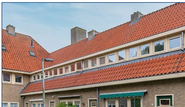
Figuren 4. Bij dakkapellen die doorlopen bij de burens is het aan te bevelen om de hele rij tegelijkertijd goed te isoleren en van nieuwe dakbedekking te voorzien. Rechts . Bij rijtjeswoningen waar zowel dakkapellen als erkers kleine platte daken hebben, is het uitvoeren van meerdere daken tegelijkertijd financieel voordeliger. Bij alle oude woningen is de isolatie van deze gebouwonderdelen zeer slecht.
