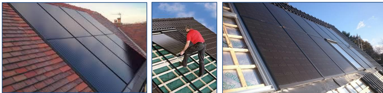
Figuren 36. PV-panelen in het dakvlak, tussen de pannen. Het leggen van PV of zonneboiler panelen in plaats van dakpannen. Geïsoleerde PV dakelementen of PV-zonneboilers op een geïsoleerd dak.
