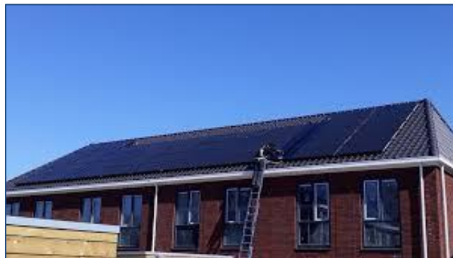
Figuren 37. Volledig PV-dak zonder dakpannen, ook bestaand met dunne buigzame PV-folies. PV-dakpannen van Roofon.nl, ook bestaand in rode dakpannen. Dit laatste is soms mogelijk bij beschermd stadsgezicht.
