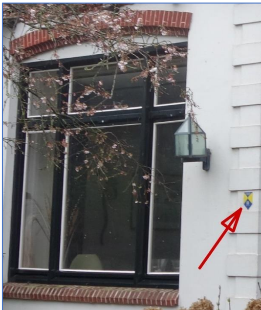
Figuren 8. Monument (pijl) met erg slecht isolerend monumentenglas (Rg 0,2). Rechts . IR foto van binnenuit.
