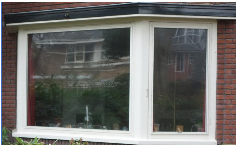
Figuren 5. Links . Jaren '30 woning met oud isolatieglas. Geen meerwaarde woning. Aan de binnenkant zijn grote Polycarbonaatplaten gezet; deze werden direct bij de kunststofhandel op maat besteld. Aan de buitenreflectie van de ramen van het andere gebouw is een lichte vertekening te zien. Rechts . Boerderij uit 1800. Buitenzijdige voorzetruiten van Acrylaat (Belned), al 30 jaar glashelder.
