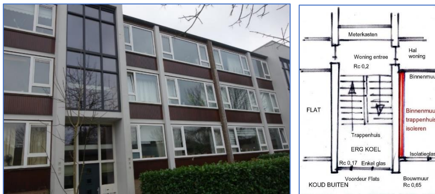
Figuren 15. Gemeenschappelijke entree van een VVE met koud trappenhuis. Hier kan alleen aan de woningkant de muur van het trappenhuis worden na-geïsoleerd.
