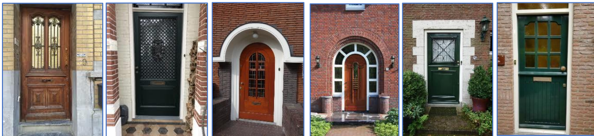
Figuren 1. Voordeuren van oud naar nieuw geven voor de eigenaar identiteit aan een woning. In de meeste oudere voordeuren zit enkel glas of Glas-in-lood raampjes, de slecht isoleren. Ook kunnen ze kieren.
