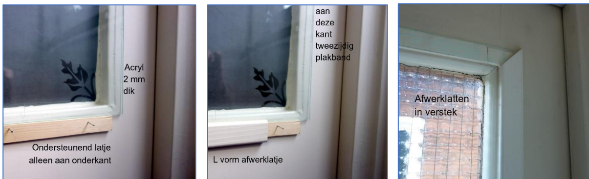
Figuren 7. Bij bewegende deuren is het verstandig om de grote Acrylplaat op een latje te stellen, zodat deze plaat niet alleen aan het tweezijdige plakband hangt. Op de hoeken de afwerklatten in verstek aanbrengen.
