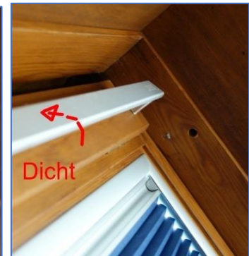
Figuren 5. Links : Dit dakramen heeft een aluminium afstandhouder in het glas. De eerste 8 cm vanaf de zijkant van het glas is daarom het minst isolerende oppervlakte. Hierdoor ontstaat condens langs die randen.
