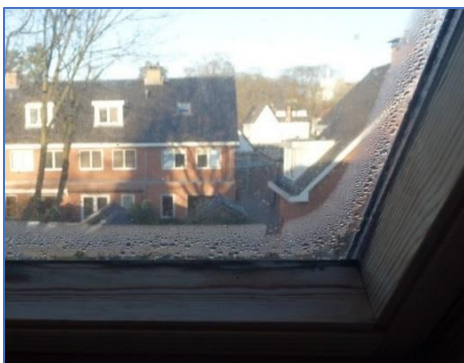
Figuren 5. Links : Dit dakramen heeft een aluminium afstandhouder in het glas. De eerste 8 cm vanaf de zijkant van het glas is daarom het minst isolerende oppervlakte. Hierdoor ontstaat condens langs die randen.
