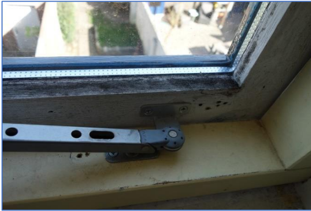
Figuren 3. Links : Isolatieglas met schimmelvorming op het niet-geschilderde raamhout. Rechts : Tussen glasplaten zonder Low-E coating bestaat een lage isolatiewaarde ( R_c = 0,4 ) waardoor condens slecht geschilderd hout aantast. Verf gaat eerst barsten, dan dringt er meer vocht in het hout dat dan gaat rotten.
