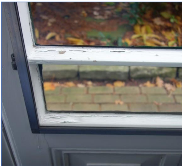
Figuren 4. Links : Buiten enkel glas en binnen een achterzetruit. Vocht is achter de ruit gekomen en de verf breekt door zwelling van het hout, waardoor er weer meer vocht in het hout kan trekken en het gaat rotten. Rechts : Enkel glas ruit met condens druppels. De kitvoeg heeft hier zwarte schimmelaafzetting in de hoek.
