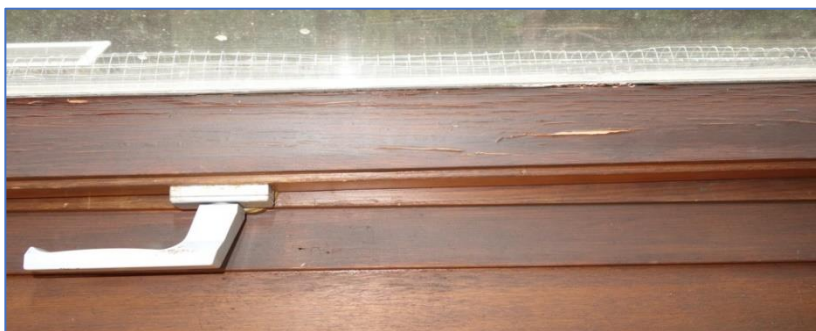
Figuren 6. Onderrand dakraam met zichtbare aantasting van het verfwerk.
