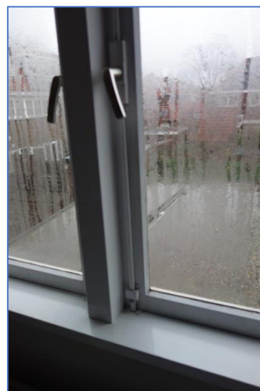
Figuren 6. Onderrand dakraam met zichtbare aantasting van het verfwerk.
