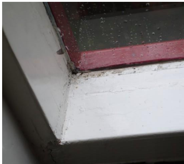
Figuren 4. Links : Buiten enkel glas en binnen een achterzetruit. Vocht is achter de ruit gekomen en de verf breekt door zwelling van het hout, waardoor er weer meer vocht in het hout kan trekken en het gaat rotten. Rechts : Enkel glas ruit met condens druppels. De kitvoeg heeft hier zwarte schimmelaafzetting in de hoek.
