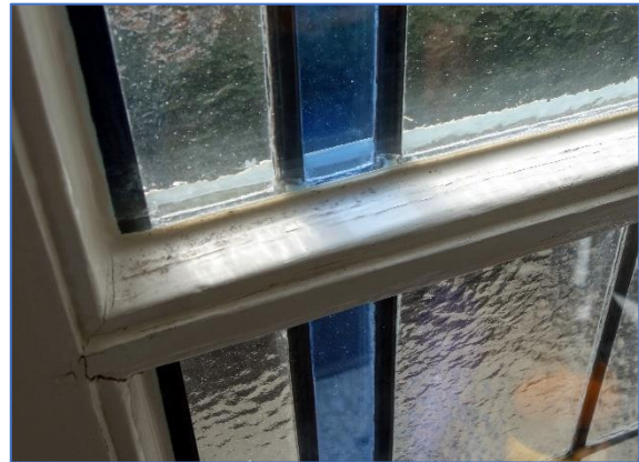
Figuren 3. Links : Isolatieglas met schimmelvorming op het niet-geschilderde raamhout. Rechts : Tussen glasplaten zonder Low-E coating bestaat een lage isolatiewaarde ( R_c = 0,4 ) waardoor condens slecht geschilderd hout aantast. Verf gaat eerst barsten, dan dringt er meer vocht in het hout dat dan gaat rotten.
