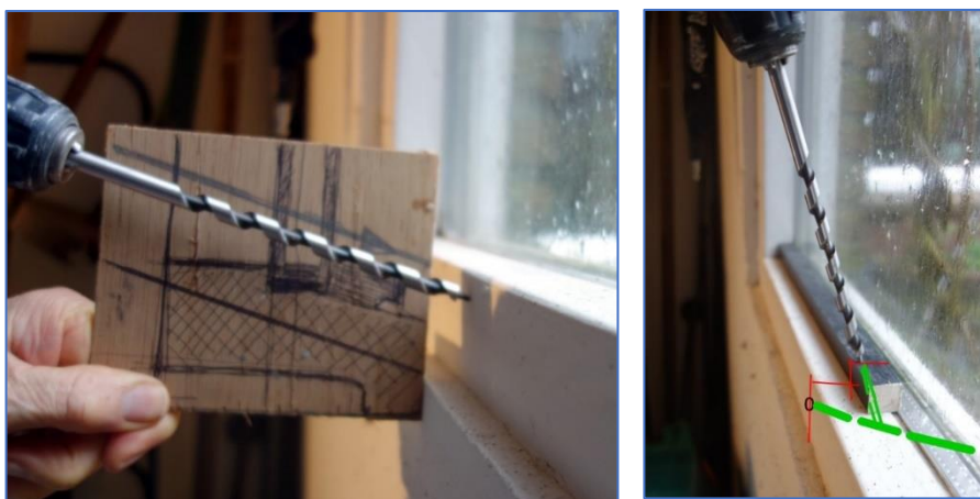
Figuren 15. Links het \varnothing 8 mm schuin naar buiten aflopende gat.
