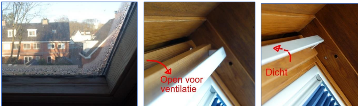
Figuren 5. Links . Het houtwerk van de dakramen met isolatieglas en de aluminium afstandshouder in het glas zijn de minst isolerende oppervlaktes. Bij zolders waar de was gedroogd wordt, treedt daar dan condensatie op. De bovenklep (handvat) van het dakraam moet dan naar beneden gedraaid worden om voor constante ventilatie te zorgen. Het houtwerk moet ook goed onderhouden worden.
