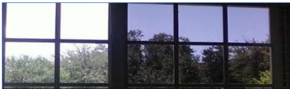
Figuur 22. Zonwerende folie moet altijd aan de buitenzijde zitten en kan verschillende sterktes hebben, eenmaal op alle ruiten geplaatst is het verschil niet te zien.
