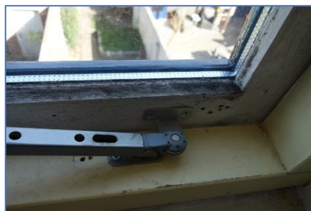
Figuur 28. Afhankelijk van de plaats van het raamwerk en de staat van onderhoud kan besloten worden om het raamwerk te vervangen voor een beter isolerende/ventilerende oplossing.
