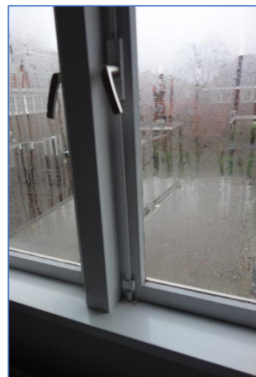
Figuren 5. Links . Het houtwerk van de dakramen met isolatieglas en de aluminium afstandshouder in het glas zijn de minst isolerende oppervlaktes. Bij zolders waar de was gedroogd wordt, treedt daar dan condensatie op. De bovenklep (handvat) van het dakraam moet dan naar beneden gedraaid worden om voor constante ventilatie te zorgen. Het houtwerk moet ook goed onderhouden worden.
