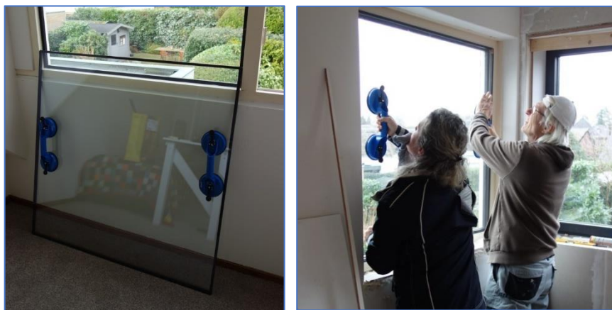
Figuren 16. Als de ruiten goed schoon zijn, bevestig de zuignappen en zet de ruit tegen de spouwlaten.
