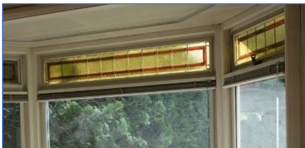
Figuren 7. Bij dit GiL bovenraam zit er al aan de binnen zijde een aluminium frame binnen achterzetruit (Rc = 0,4). Door die binnen achterzetruit naar de buitenkant over te zetten, wordt het GiL goed beschermd. Aan de binnenkant kan dan een HR ++ geplaatst worden een luchtspouw van 18 mm (nieuwe Rc = 0,4 + 0,2 + 0,9 = 1,5) wat ≈3x zoveel isolatiewaarde oplevert.
