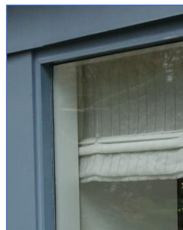
Figuur 23. Verschillende opties voor de buitenzijdige opbouw van het houten kozijn met de glaslat aan de buitenkant of in de dag van het kozijn. Dit heeft de voorkeur boven het uitfrezen van het kozijn.
