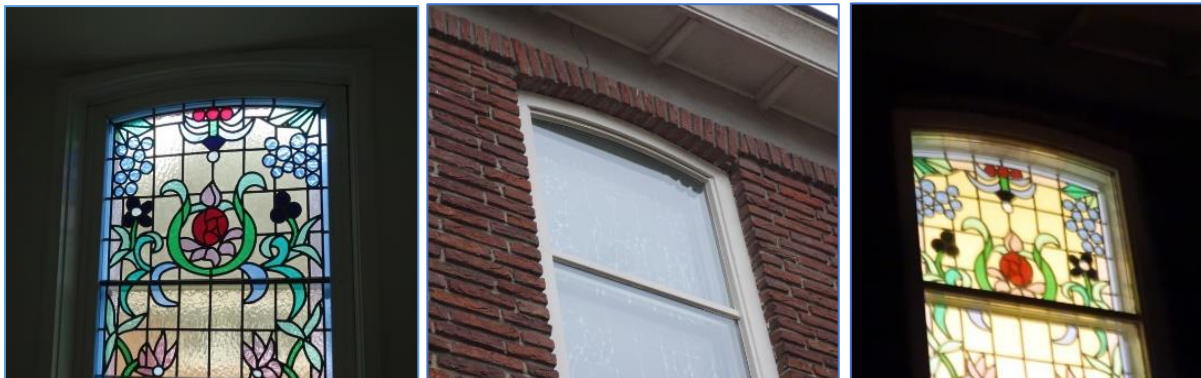
Figuren 18. Links : GiL overdag van binnenuit. Midden : Overdag van buiten. Rechts : 's nachts van buitenaf gezien met verlichting binnen. Dit is een vaste HR + isolatieruit met binnen het GiL-raam in een eigen frame.
