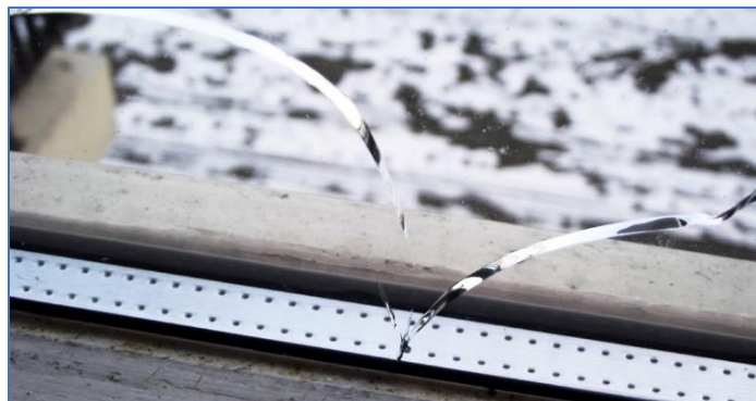
Figuur 21. Thermische breuk vanuit de spacer door hoge spanningen in het glas door grote temperatuurverschillen en vaak in combinatie met bestaande rand beschadiging.
