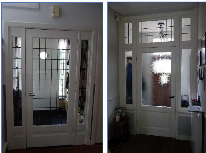
Figuren 13. Klassieke tochtdeuren van verschillende formaten. Het beweegbare gedeelte moet bij voorkeur van niet-breekbaar kunststof zijn.
