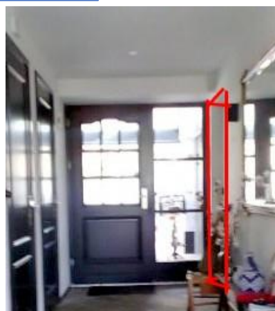
Figuur 11. Bij deze voordeur loopt er een gang naar rechts (rood kader). Hier zou een gordijn aan de latei boven de deur gemaakt kunnen worden en in de zomer voor het raam rechts van de deur hangen.
