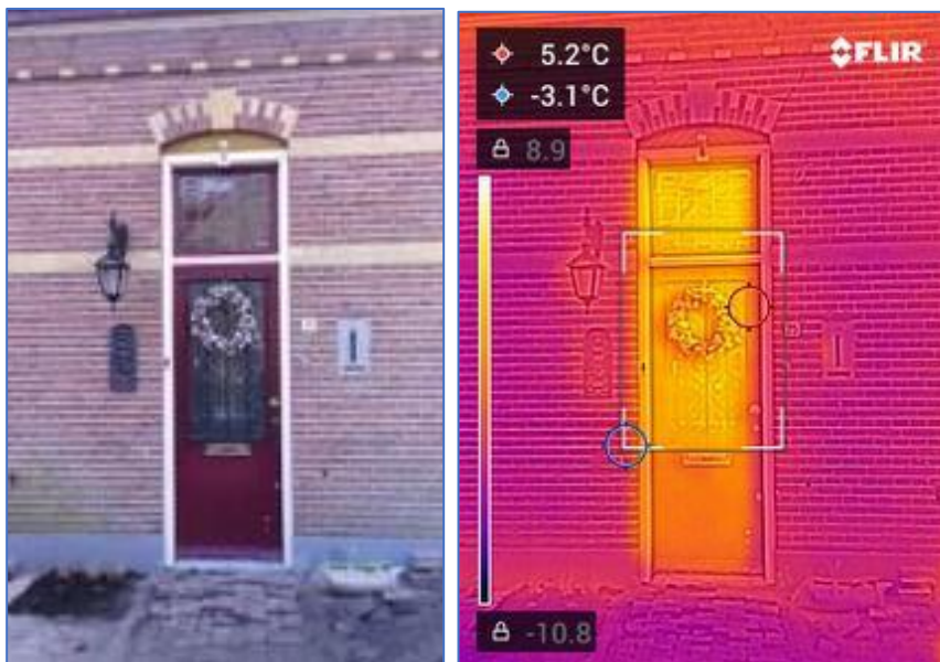
Figuren 2. Infrarood foto in de winter. De glas-in-lood ruiten geven het meeste warmteverlies aan ( R_c = 0,17 ), maar de houten deur zelf ook ( R_c = 0,2 ).
