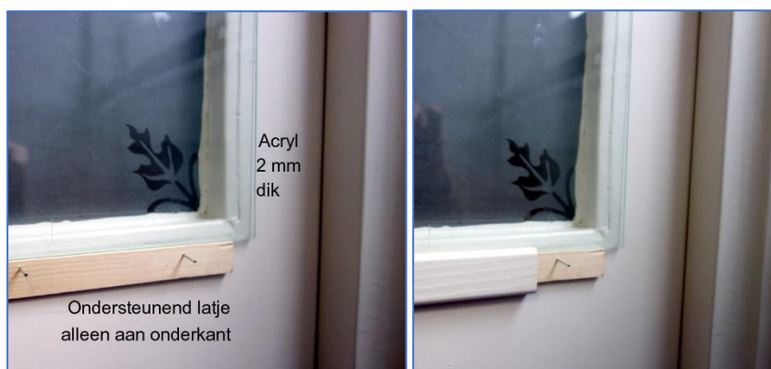
Figuren 4. Links: Acrylplaat vastgezet met kleine schroefjes, niet afgewerkt. Gevaar van barsten bestaat hier. Midden: Toepassing tweezijdig plakband waar de kleine Acrylplaten op worden vastgezet. Rechts: Nette afwerking met ongelijkzijdige hoeklat geverfd in de kleur van de deur, en vastgezet met tweezijdig plakband.
