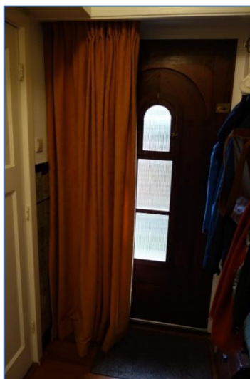
Figuren 1. Het dikke, rondom goed afsluitende gordijn (boven, onder en aan de zijkanten) en de nieuwe tochtdeur zijn de meest effectieve maatregelen om de voordeur beter te isoleren.
