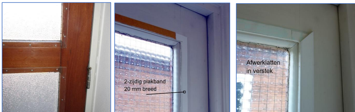
Figuren 4. Links: Acrylplaat vastgezet met kleine schroefjes, niet afgewerkt. Gevaar van barsten bestaat hier. Midden: Toepassing tweezijdig plakband waar de kleine Acrylplaten op worden vastgezet. Rechts: Nette afwerking met ongelijkzijdige hoeklat geverfd in de kleur van de deur, en vastgezet met tweezijdig plakband.
