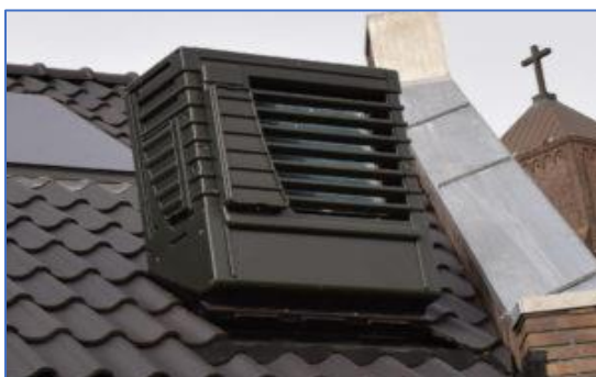
Figuren 31. Warmtepompen units op een schuin dak en de aanvullende apparatuur op zolder. Boven: Decorio. Bij een buitenunit op het dak moet voor onderhoud een monteur komen en zijn extra veiligheidsregels van toepassing. Er is ook de EQ-Air (26 dB, dus heel stil) en de Econex schuin dak unit. Rechts: Horizontale positie van een warmtepomp. Er komen regelmatig nieuwe modellen op de markt.
