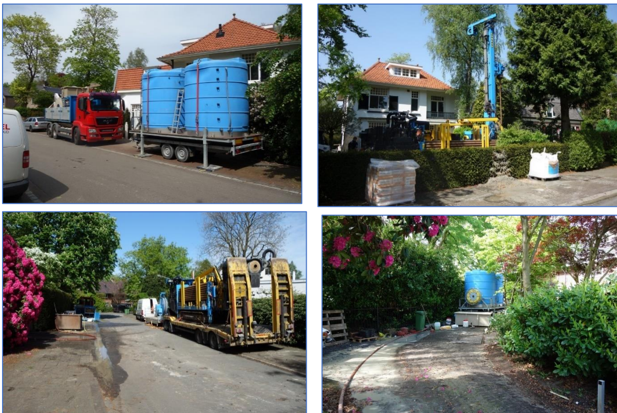
Figuren 9. Vrachtwagens voor de boorinstallatie en opgerichte boorinstallatie. Na afloop moet de tuin weer opnieuw aangelegd. Zonde brede toegang kan ook tijdelijk de heg opzij geplaatst worden.
