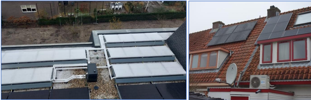
Figuur 22. Links. Van Triple Solar. Rij op PVT. Bij deze foto zijn de verbindende leidingen te zien. Bij de planning voor de beschikbare ruimte moet met die leidingen rekening gehouden worden. Rechts. Op de linker tussenwoning vier panelen Triple Solar. Op de rechter woning gewone PV en airco.
