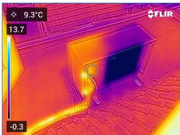
Figuren 27. Kleine (hybride) warmtepomp op een dakje. Wanneer de CV eruit gaat komt hier een tweede kleine warmtepomp ernaast. De leiding mag wel wat beter geïsoleerd zijn.
