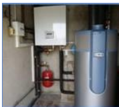
Figuren 33. Links. Hybride warmtepomp en de HR-Cv met rechts (grijs) de omvormer voor de PV. Midden. Voorbeeld van een Lucht-Water warmtepomp binnen opstelling met een buffervat. Rechts. Ducobox Eco met buffervat om koude-pieken op te vangen.
