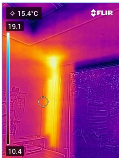
Figuren 21. Verticale design radiator. Infra-Rood foto en de gewone foto.
