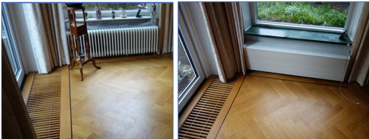
Figuren 1. Een LTV-vloerverwarming is niet altijd nodig. Wanneer u bijvoorbeeld een mooie vloer heeft, zou u die niet willen slopen om daar een LTV-vloerverwarming in/op te bouwen. Links . Oude situatie met oude radiator. Rechts . Toepassing van binnenzijdige muurisolatie tot een Rc 4 m 2 .K/W (bredere vensterbank) en plaatsing van een Jaga of Henrad convectorradiator met ventilator. Dit kan ook in de convectorbak maar die kan ook dicht.
