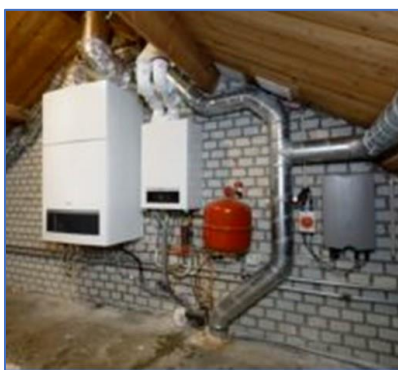
Figuren 33. Links. Hybride warmtepomp en de HR-Cv met rechts (grijs) de omvormer voor de PV. Midden. Voorbeeld van een Lucht-Water warmtepomp binnen opstelling met een buffervat. Rechts. Ducobox Eco met buffervat om koude-pieken op te vangen.
