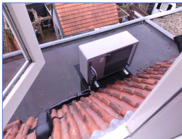
Figuren 27. Kleine (hybride) warmtepomp op een dakje. Wanneer de CV eruit gaat komt hier een tweede kleine warmtepomp ernaast. De leiding mag wel wat beter geïsoleerd zijn.
