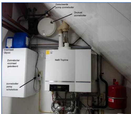
Figuren 28. Een zonneboiler genereert over een jaar ongeveer 50% van de tapwater warmte, maar weinig in de winter. Links de geïsoleerde tussen-opslagtank. De
