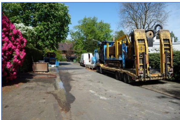
Figuren 9. Vrachtwagens voor de boorinstallatie en opgerichte boorinstallatie. Na afloop moet de tuin weer opnieuw aangelegd. Zonder brede toegang kan ook tijdelijk de heg opzij geplaatst worden.
