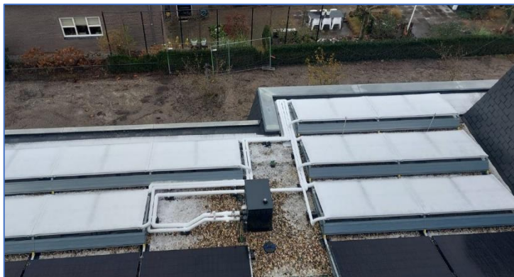
Figuur 19. Van Triple Solar. Rijp op PVT. Bij deze foto zijn de verbindende leidingen te zien. Bij de planning voor de beschikbare ruimte moet met de leidingen rekening gehouden worden.
