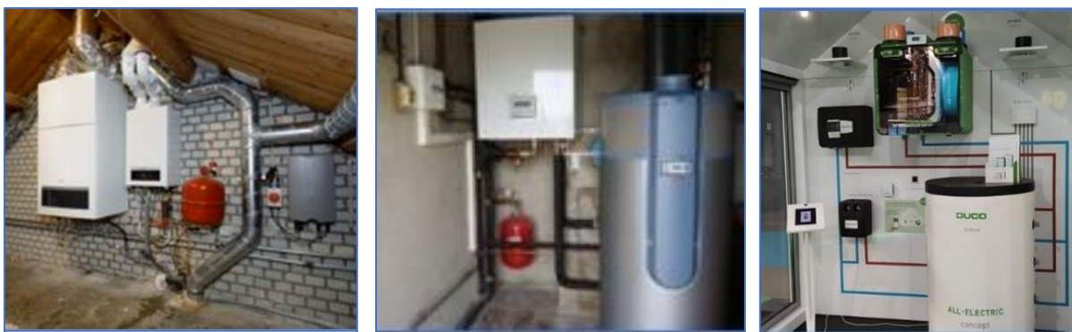
Figuren 26. Links. Hybride warmtepomp en de HR Cv met rechts (grijs) de omvormer voor de PV. Midden. Voorbeeld van een Lucht-Water warmtepomp binnen opstelling met een buffervat. Rechts. Ducobox Eco met buffervat om koude-pieken op te vangen.
