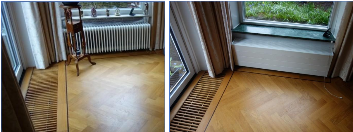
Figuren 1. Een LTV-vloerverwarming is niet altijd nodig. Wanneer u een mooie parketvloer heeft, zou u die niet willen slopen om daar een LTV-vloerverwarming in/op te bouwen. Links . Oude situatie met oude radiator. Rechts . Toepassing van binnenzijdige muurisolatie tot een R_c > 4 \text{ m}^2 \cdot \text{K/W} (brede vensterbank) en plaatsing van een Jaga convectorradiator met ventilator. In de convectorbak is ook een nieuwe convectorradiator geplaatst. Bij een goede gebouwisolatie en LTV kunnen vaak de oude radiatoren blijven zitten en voorzien worden van radiator-ventilatoren voor een versnelde warmteafgifte.
