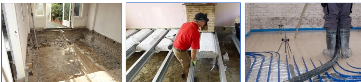
Figuren 2. Het verhogen van de bestaande vloer of het aanleggen van een geheel nieuwe vloer met LTV houdt veel werk in, maar met een betere gebouwisolatie en radiatorventilatoren kan ook goed verwarmd worden.
