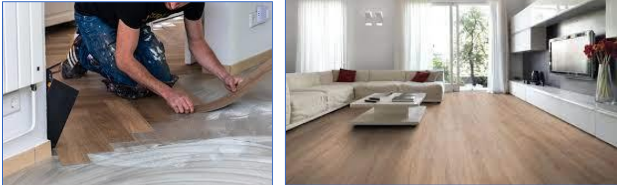
Figuren 25. Nieuwe PVC-vloeren komen in veel verschillende 'houten' parket ontwerpen zoals visgraat en stroken en zijn nauwelijks van echt houten parket te onderscheiden. Direct op de cementvloer geplakt.
