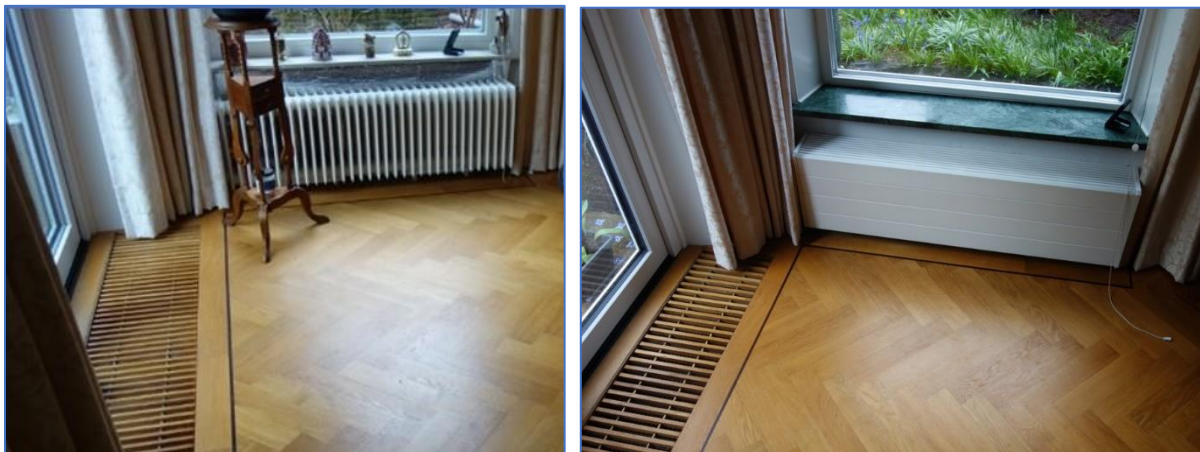
Figuren 1. Een LTV-vloerverwarming is niet altijd nodig. Wanneer u een mooie parketvloer heeft, zou u die niet willen slopen om daar een LTV-vloerverwarming in/op te bouwen. Links . Oude situatie met oude radiator. Rechts . Toepassing van binnenzijdige muurisolatie tot een R_c > 4\text{ m}^2\cdot\text{K/W} (brede vensterbank) en plaatsing van een Jaga convectorradiator met ventilator. In de convectorbak is ook een nieuwe convectorradiator geplaatst. Bij een goede gebouwisolatie 7 en LTV kunnen vaak de oude radiatoren blijven zitten en voorzien worden van radiator-ventilatoren voor een versnelde warmteafgifte.
