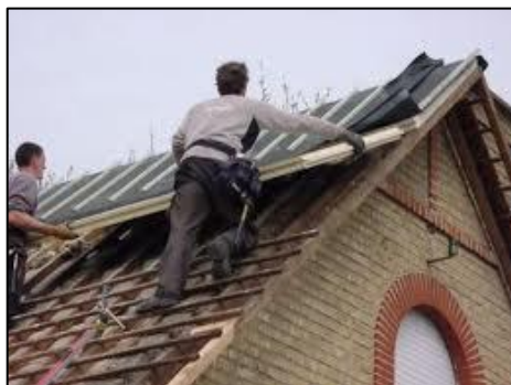
Figuren 30. Eenvoudige methode met garantie van de isolatiewaarde en regendoorslag werende folie. Beperkte dikte is ook beperkte toevoeging isolatiewaarde.
