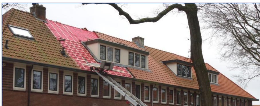
Figuur 20. Verschillende fasen van dakpannen vernieuwing in een blok. De regels zorgen ervoor dat er geen vocht achter de panlatten blijft staan.
