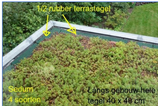
Figuur 42. Bij standaardpakketten wordt grof grind voor langs de dakrand bijgeleverd; u kan ook zelf rubberen terrastegels gebruiken (bouwmarkt 40 cm x40 cm), die zijn duurder dan het grind. (Ze zijn in tweeën te zagen om langs de rand te leggen).
