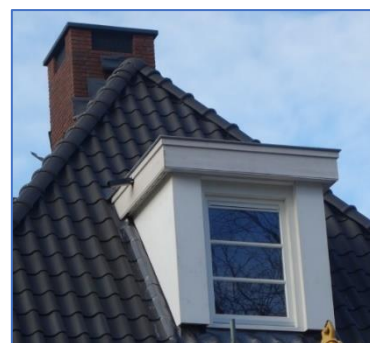
Figuren 23. Links : Oude dakkapellen met dunne, niet geïsoleerde zijkanten of dakje. Wanneer de zijkant binnenzijdig geïsoleerd wordt kan het raam niet meer open. Wanneer het buitenzijdig geïsoleerd wordt dan moet het dak overstek breder gemaakt worden.
