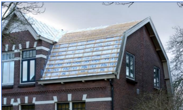
Figuren 19. Boven: Toepassing van Polytext damp-open regendoorslag werende dakfolie bij vernieuwing dakbedekking geeft geen extra isolatie.
