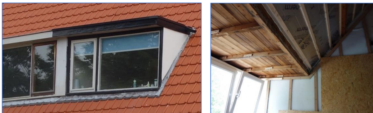
Figuren 23. Links : Oude dakkapellen met dunne, niet geïsoleerde zijkanten of dakje. Wanneer de zijkant binnenzijdig geïsoleerd wordt kan het raam niet meer open. Wanneer het buitenzijdig geïsoleerd wordt dan moet het dak overstek breder gemaakt worden.
