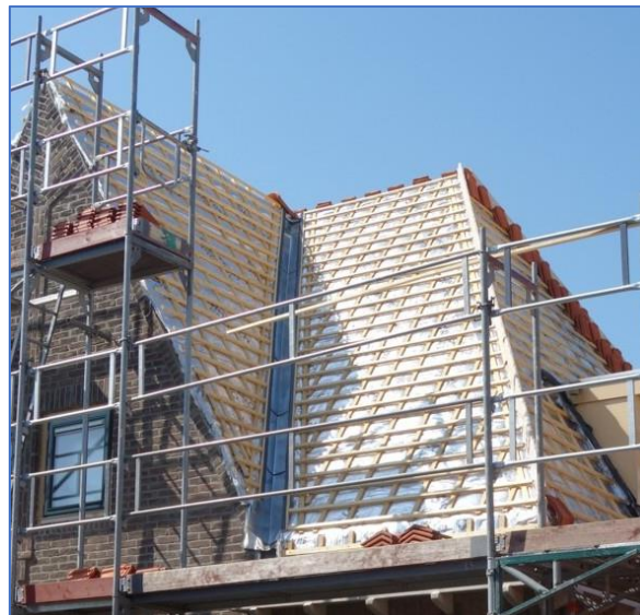
Figuren 19. Boven: Toepassing van Polytext damp-open regendoorslag werende dakfolie bij vernieuwing dakbedekking geeft geen extra isolatie.
