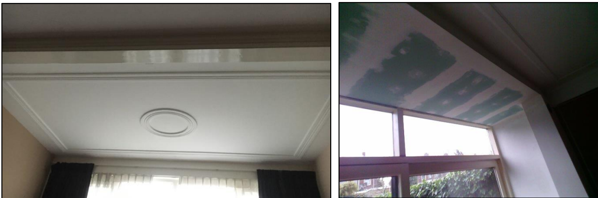
Figuren 39. Links : een plafond onder een balkonuitbouw. Het plafond eruit en tussen de balken is een oplossing met balkondeuren kort op het terras. Rechts : Reparatie van een erker plafond en aansluitend op het kozijn.
