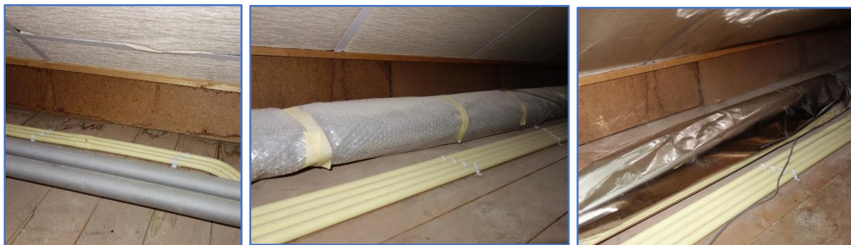
Figuren 22. Drie fasen van extra isolatie van Cv-leidingen op zolder. Links : PE-foam-buisisolatie (bouwmarkt). Midden : PE-foam + extra lagen bubbel verpakingsfolie. Rechts : PE + Bubbel + Tonzon bandage-/radiatorfolie.
