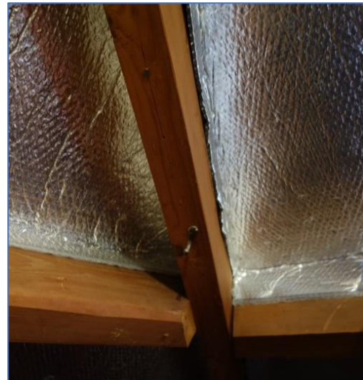
Figuur 18. Bij dit dak is binnenzijdig een enkele isolerende bubbelfolie met gemetalliseerd oppervlak aangebracht. De toegevoegde isolatiewaarde is ongeveer R_c 0,7 (> 2 cm lucht langs de HRF-zijde) wat de totale dakisolatie op R_c \approx 1,0 brengt (als er aan de buitenkant van het dakbeschoot geen isolatie is).
