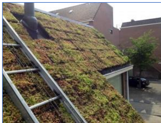
Figuur 43. Sedum-daken kunnen ook op matig hellende daken worden aangebracht, maar dat vereist het werken met cassettes en kan beter door specialisten worden gedaan. 26
