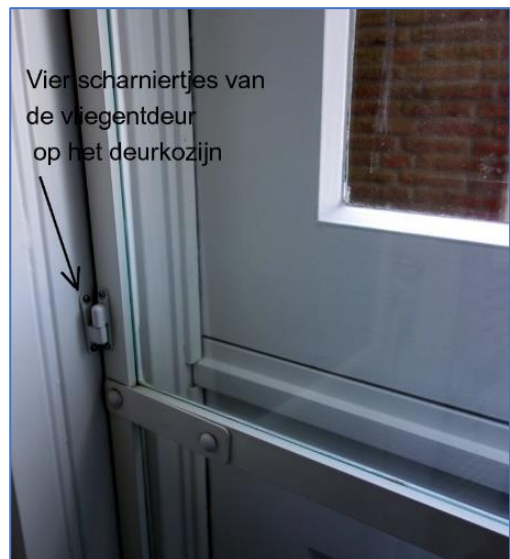
Figuur 9. De hordeur komt met vier kunststof scharniertjes die in het houten kozijn geschroefd kunnen worden. Zorg dat alle vier de scharniertjes volledig dragen op pas dunne metalen ringetjes toe.
